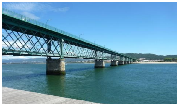
Figura 4.1 – Ponte metálica rebitada de Viana do Castelo, chamada de Ponte Eiffel [33].
