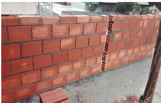
Figura 2.6 – Não Conformidade- Altura do Muro
