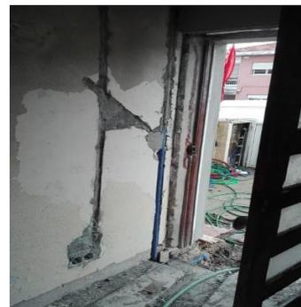
Figura 3.1 – NC- Cravação Tubagem na parede
