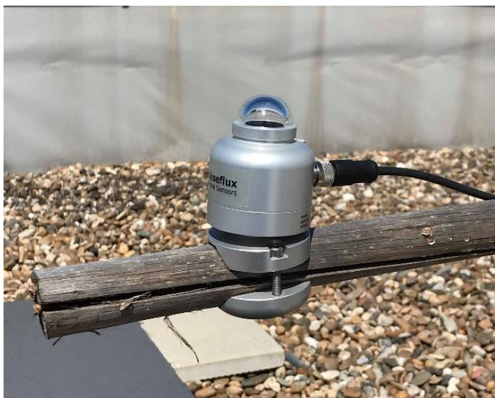
Figura 6 - Montagem do Piranómetro SR05 da Hukseflux "In Situ"
