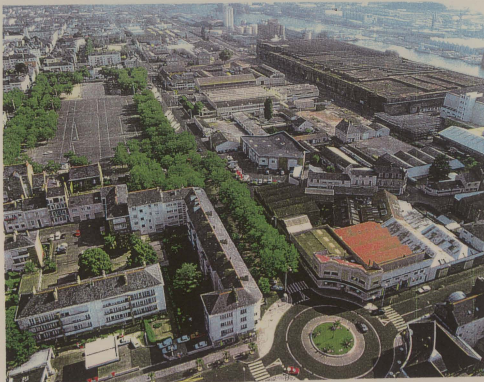
Fig. 3.17.- Fotografia actual do porto da cidade de Saint-Nazaire.
