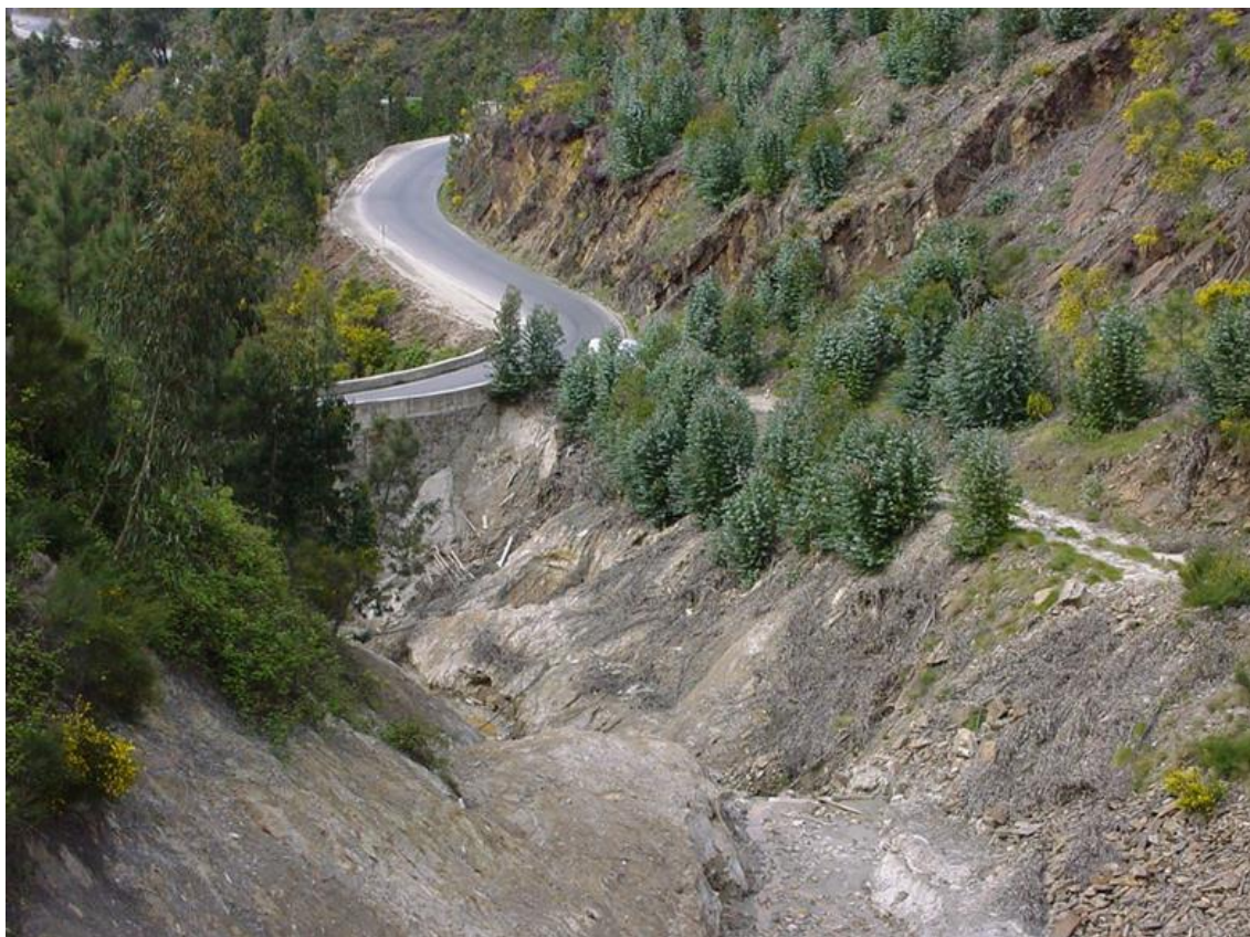
Fig. 41: materiais finos lançados da barragem de rejeitos ao longo do curso da Ribeira de Terranonte (Fonte: www.edm.pt/html/proj_terrmonete.htm ).
