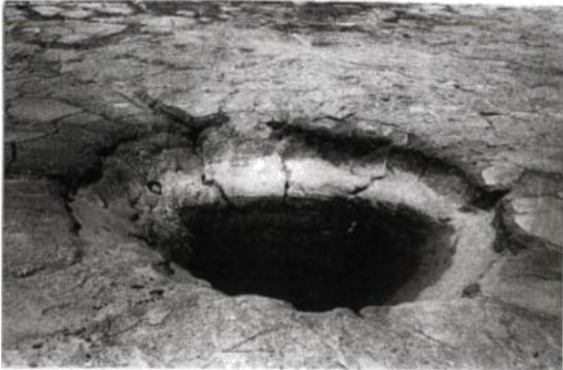
Fig. 30: Abatimento da escombreira (fonte: Nascimento, 1975 Anexo III).
