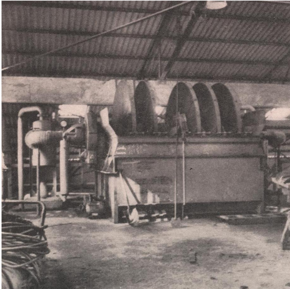
Fig. 21: Sistema de filtração dos concentrados (fonte: Koehler, 1966).
