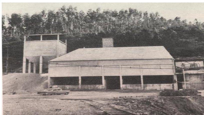
Fig. 20: Armazenamento de minério triturado no edifício da secção de flutuação. (Fonte: Koehler, 1966).
