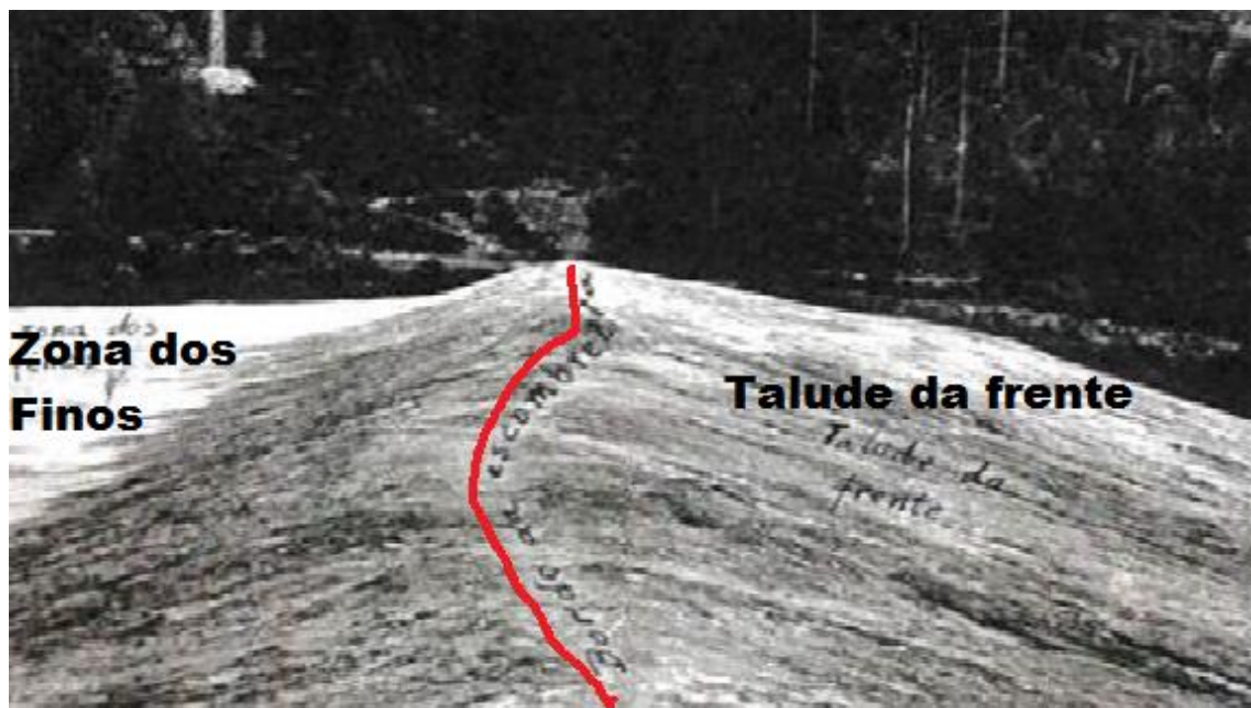
Fig. 26: Barragem de rejeitados do método jusante, marcado em vermelho o bordo da barragem. (Adaptado de Nascimento Anexo III).
