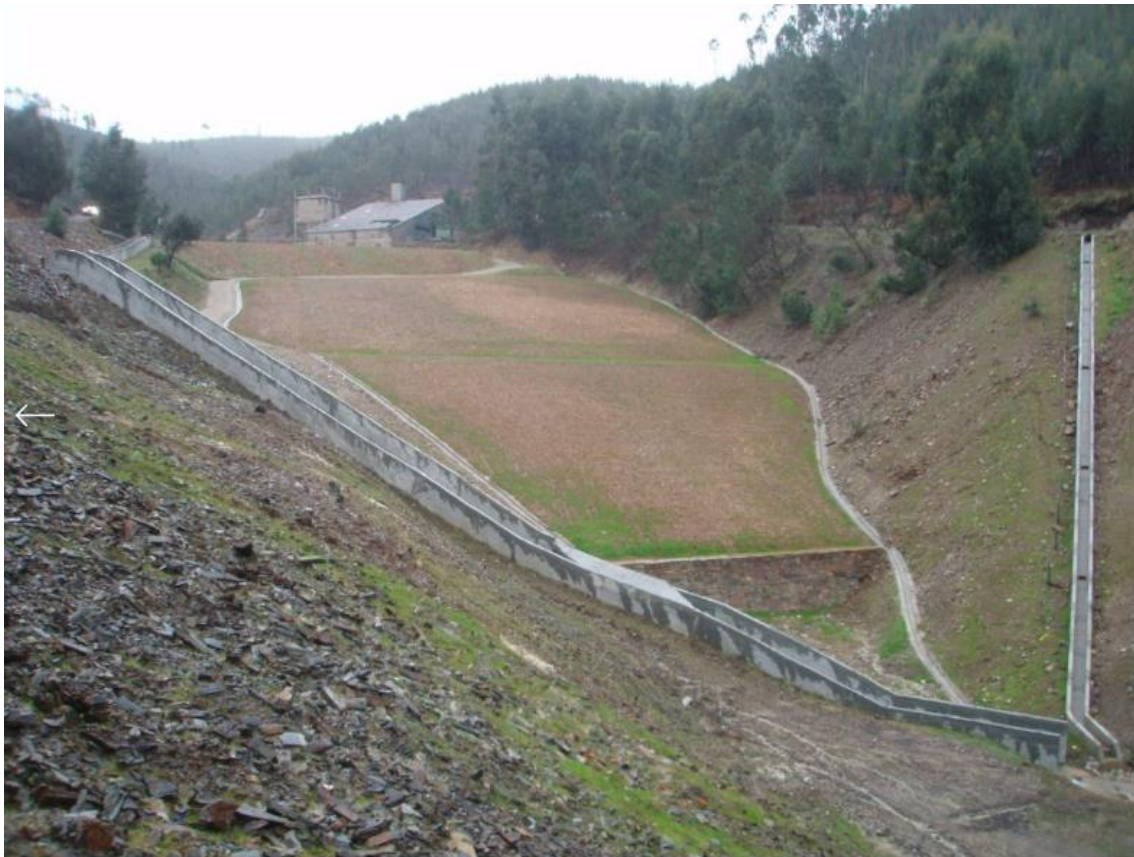
Fig. 35: Vista da barragem E1 recuperada, com a vegetação crescendo e as valetas para a drenagem das águas pluviais em torno da mesma (Fonte: www.edm.pt/html/proj_terrmonete.htm ).
