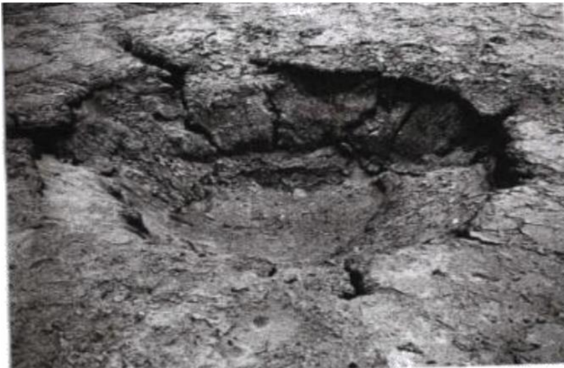
Fig. 31: Abatimento da barragem, nota-se que a mesma estava seca (Fonte: Bendayan, 1969).
