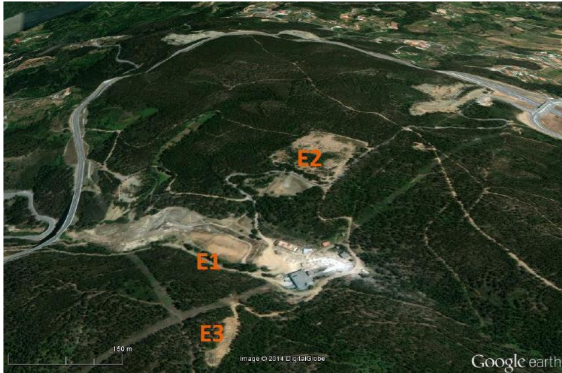
Fig. 23: Barragens da mina, E1 do tipo jusante e E2 e E3 do tipo montante. (Fonte: Soares, 2014)
