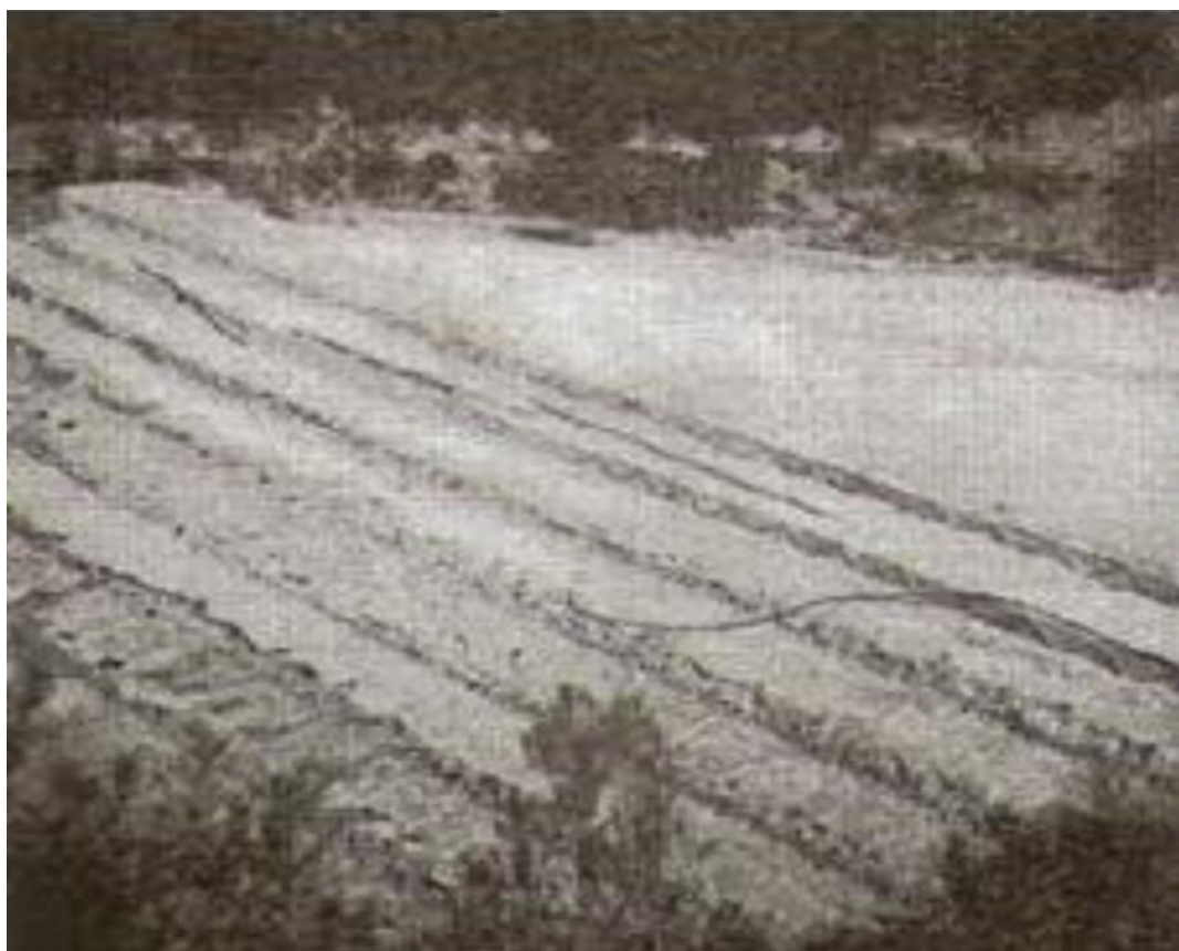
Fig. 25: Degraus formados pela deposição de rejeitados da barragem pelo método montante (Fonte: Bendayan, 1969).
