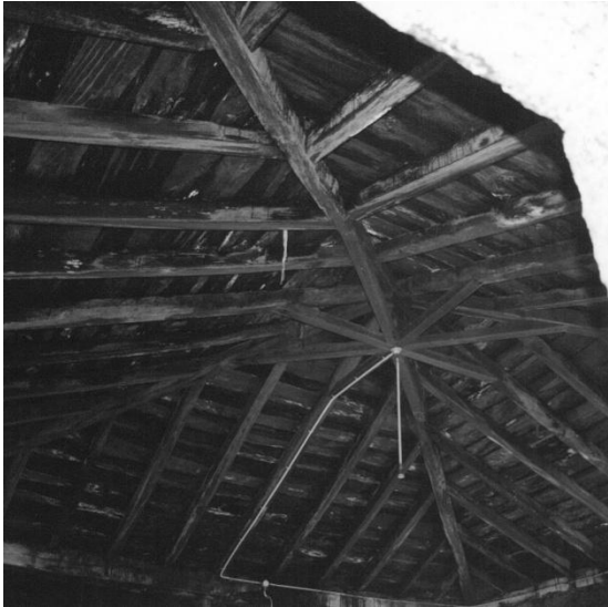
130. Estrutura da cobertura da sala grande nos anos 90
