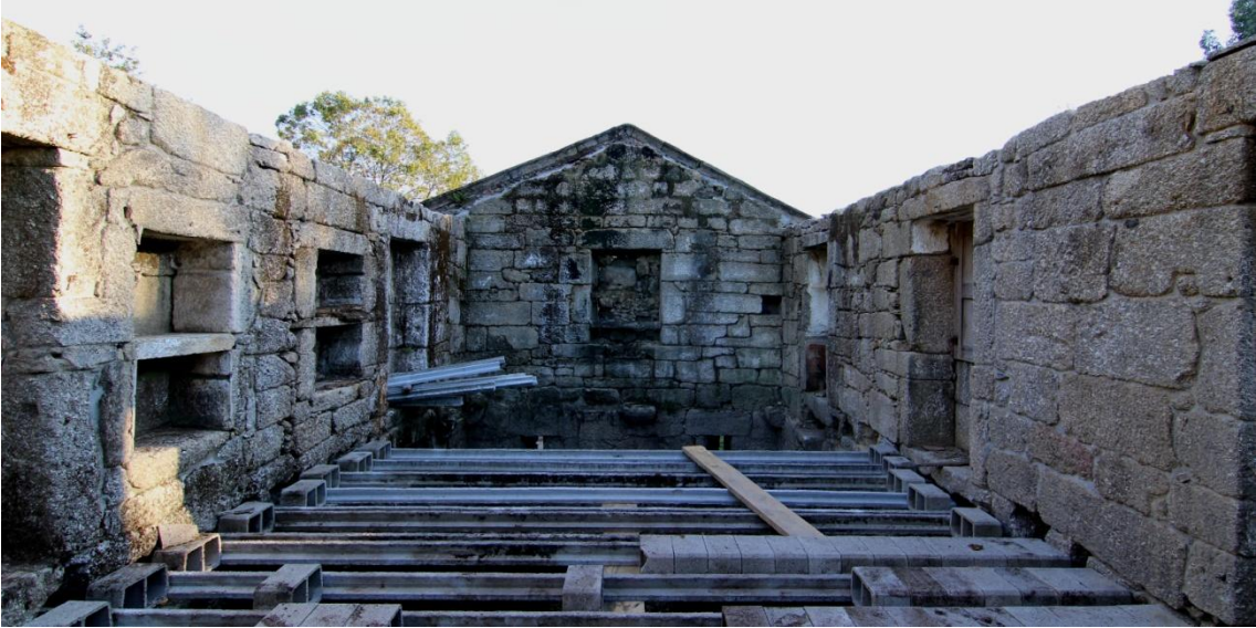
44. Piso nobre – sala grande
