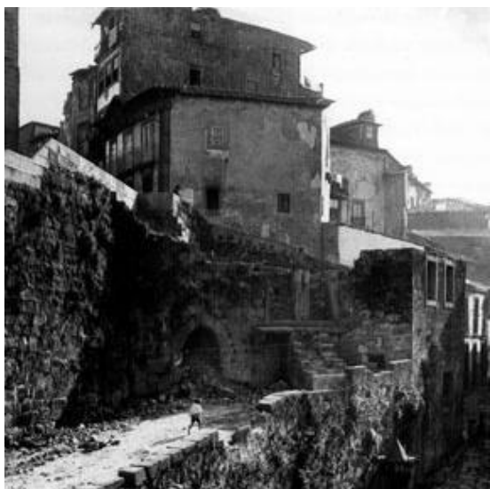
72. Casa dos 24 em ruínas
