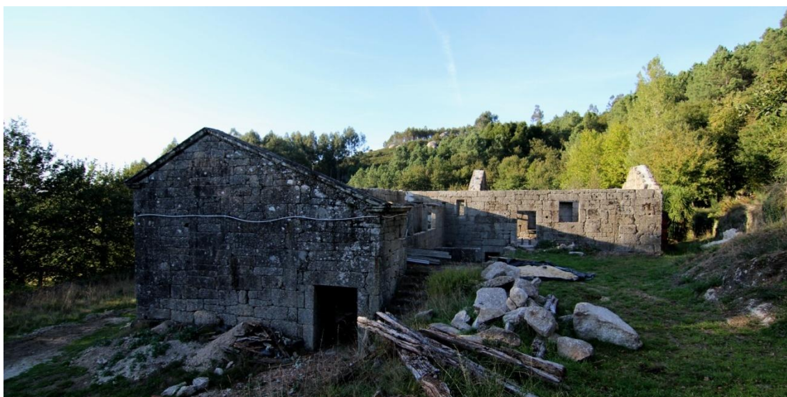
43. Alçado Sul – entradas e terreiro superior
