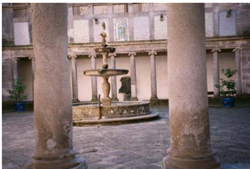
Fig. 3.9 - Claustro (Most. de Grijó)
