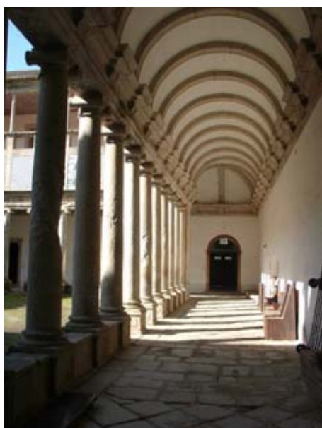
Fig. 3.10 - Galeria do claustro (Most. de Grijó)
