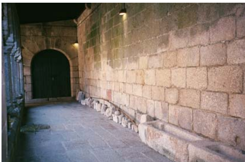
Fig. 3.13 - Galeria do claustro (Most. de Cete)
