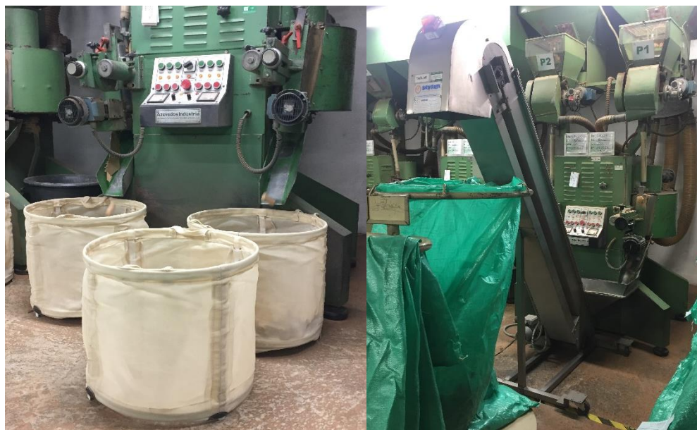
Figura 22 - Saída da máquina para alcofas e sistema de alimentação de sacos
