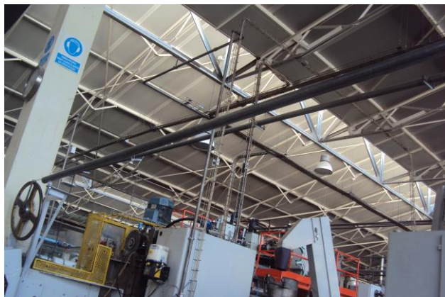
Figura 27 - Tubo de aço para proteção do arame
