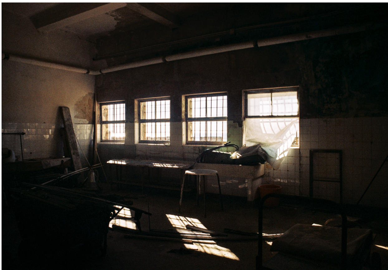
[77] Cozinha do Bloco D de serviços.
