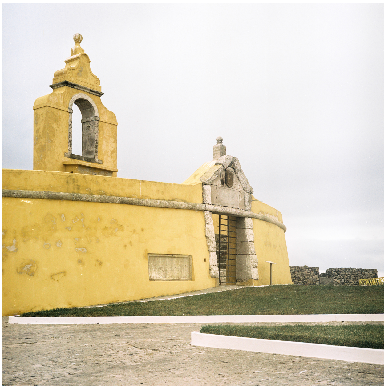
[33] Vista da praia do túnel de mar sobre a entrada da Fortaleza de Peniche.
