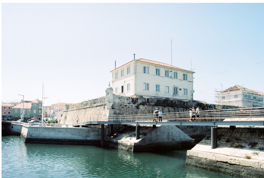
[27] Bateria da praça, ponte pedonal de acesso à antiga ilha.
