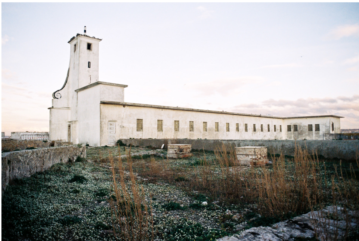
[68] Terceiro piso do Bloco C e torre de vigia - vista norte.
