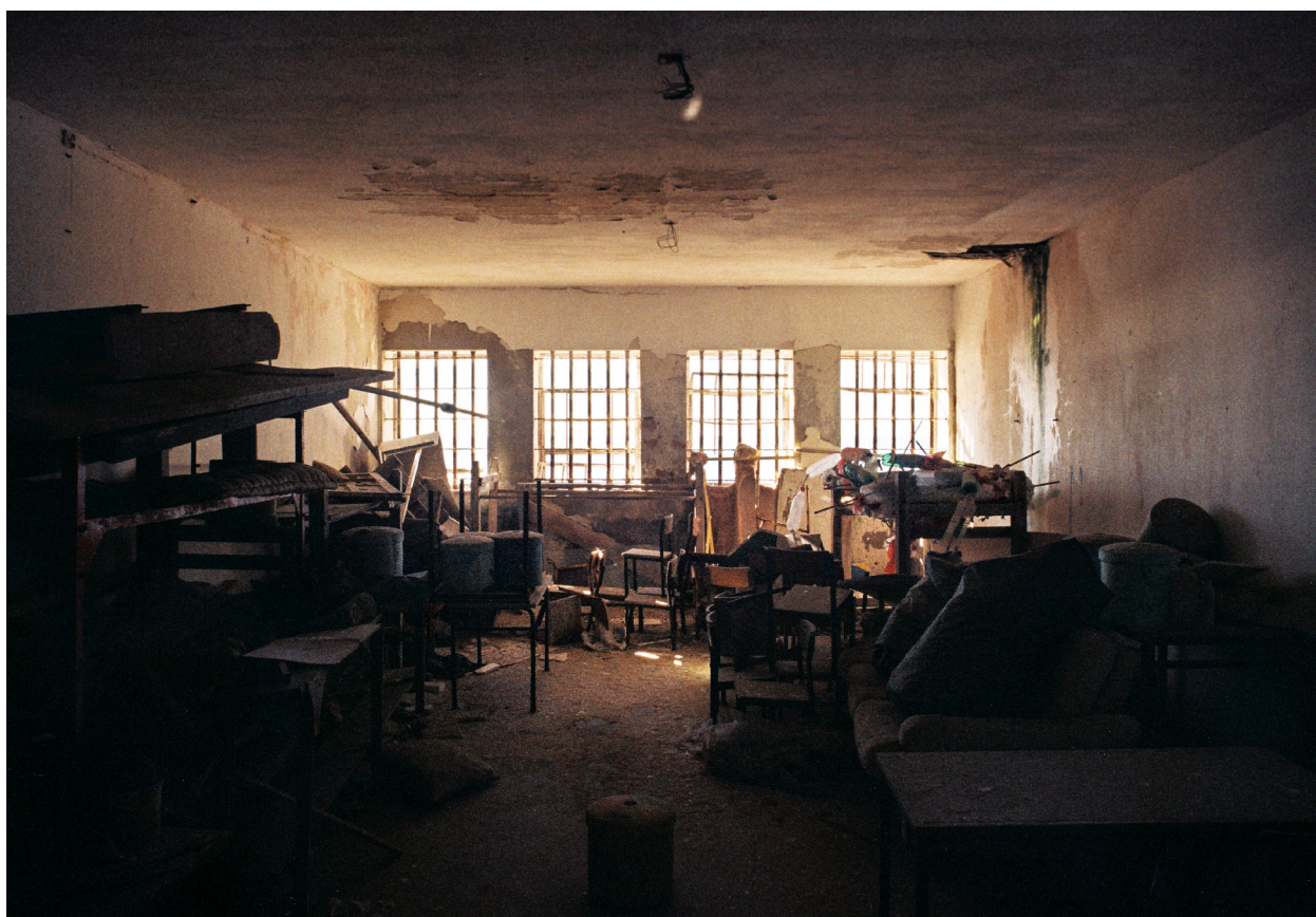
[75] Celas comuns do Bloco A.
