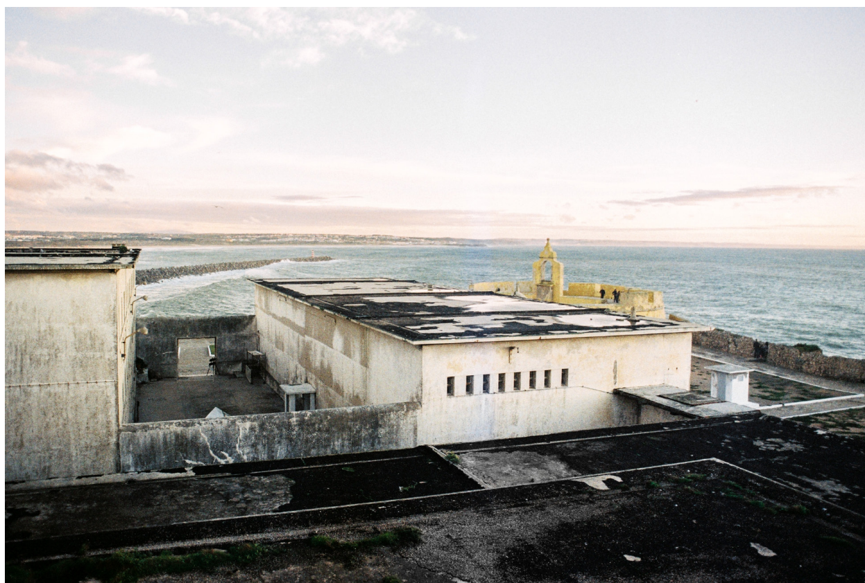
[69] Vista sobre o Bloco A e o pátio de recreio entre o Bloco A e B.
