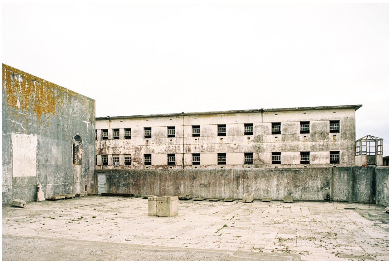
[66] Alçado norte do Bloco B, visto do pátio da cisterna grande.
