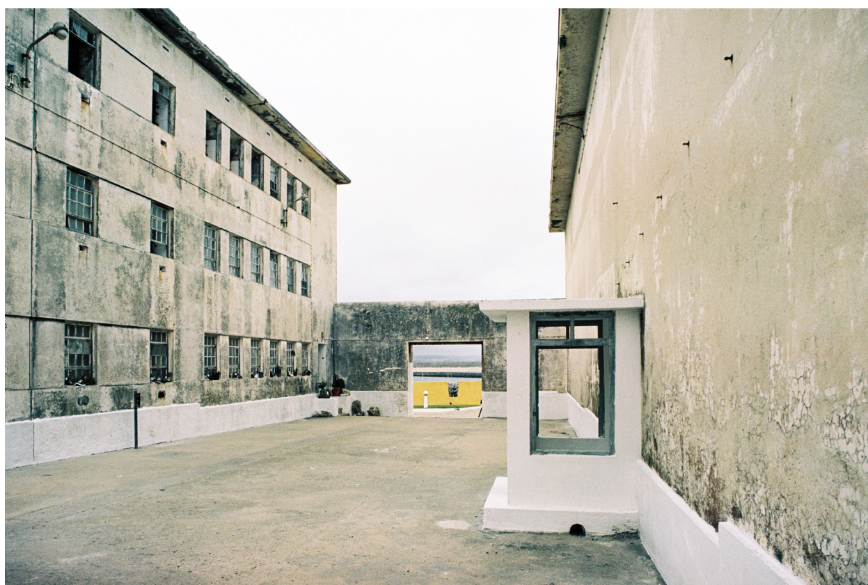
[61] Pátio de recreio entre o Bloco A e B.
