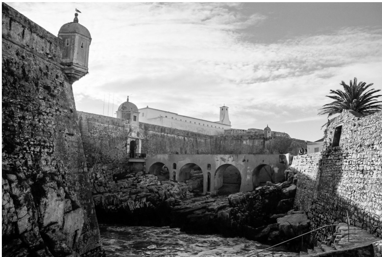
[29] Vista da praia do túnel de mar sobre a entrada da Fortaleza de Peniche.
