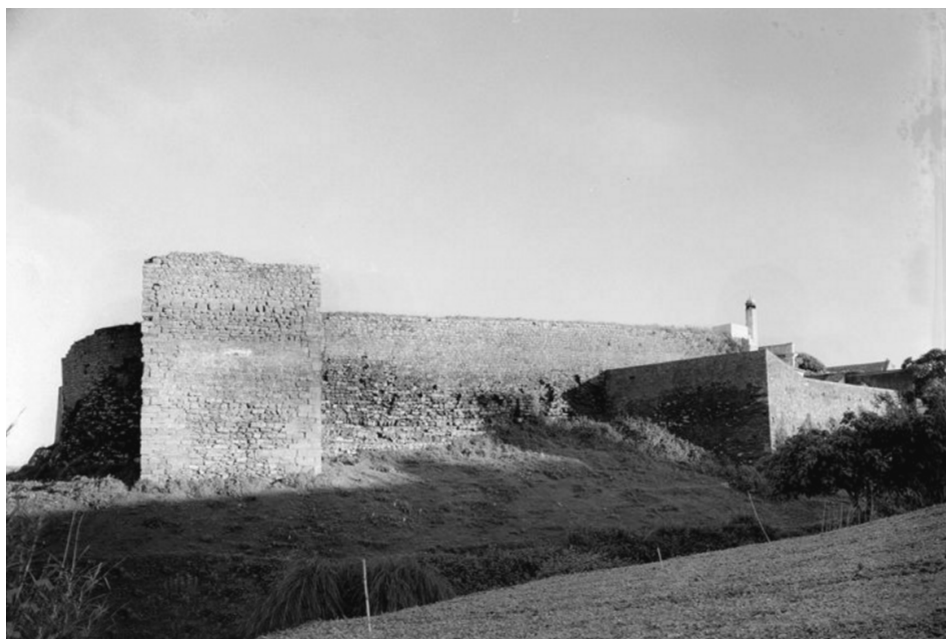
[8] Calado Castelo de Atouguia da Baleia, vista geral do lado Poente, 1961.
