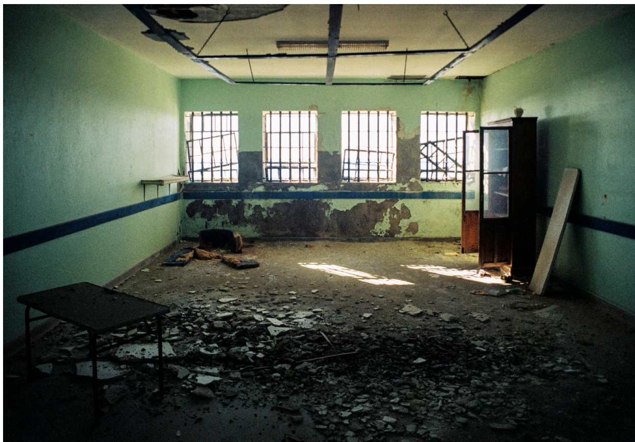
[74] Celas comuns do Bloco A.
