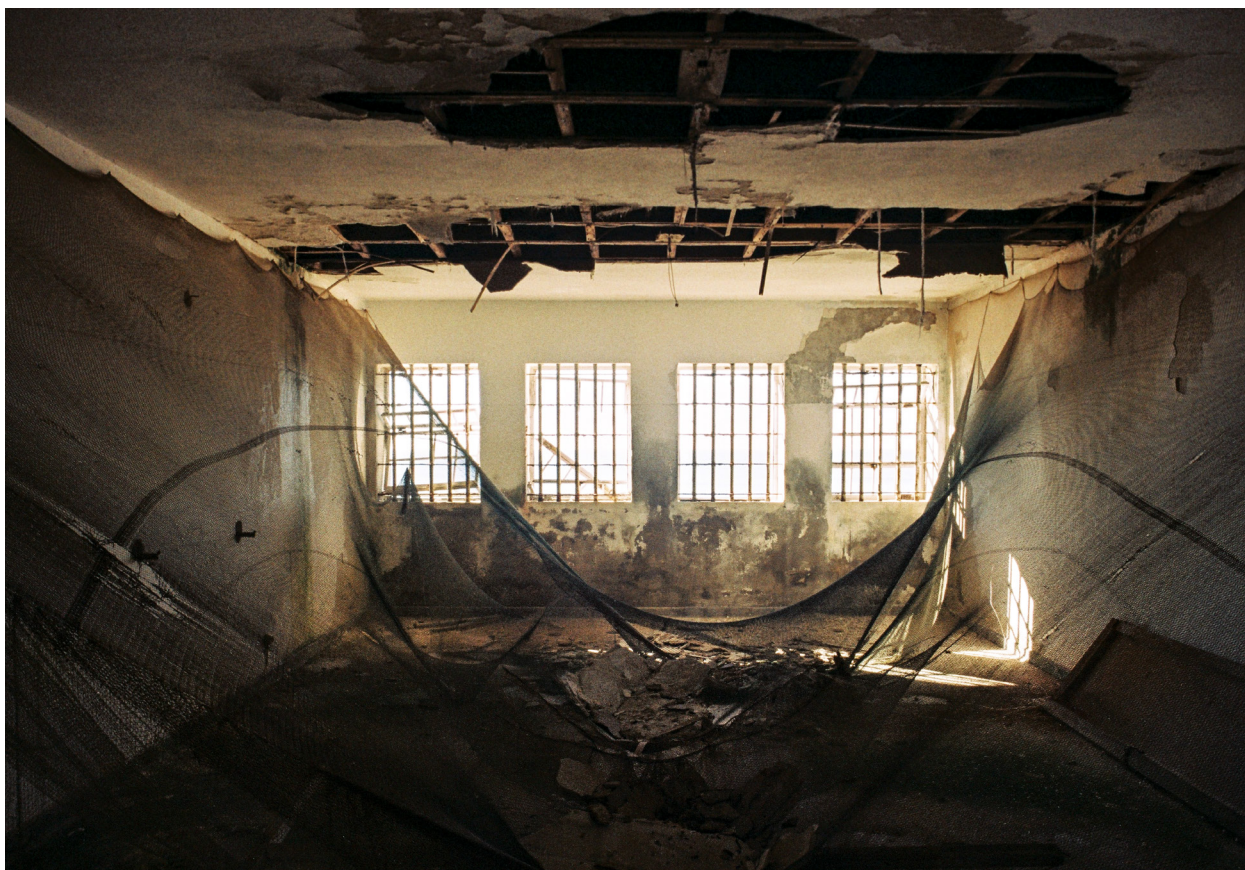
[76] Celas comuns do Bloco A.
