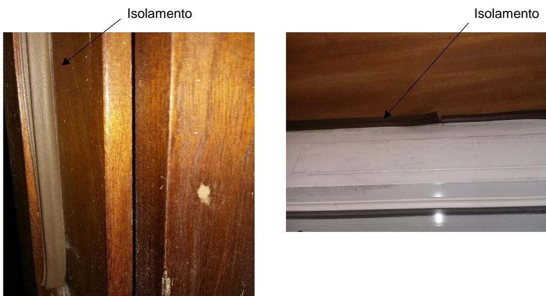
**Figura 4.6** Isolamento aplicado em janelas com fita de borracha
