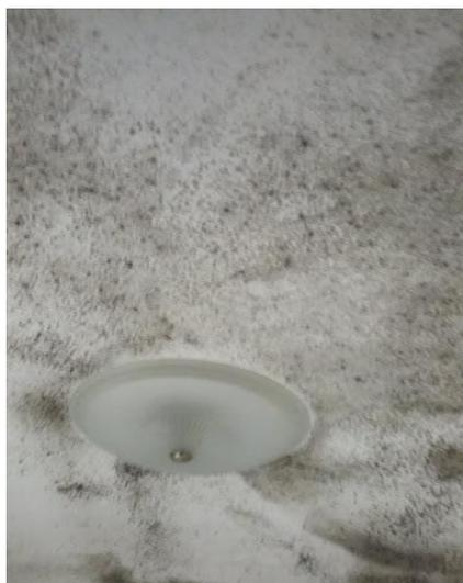
**Figura 4.10** Teto com humidade provocada por condensação
