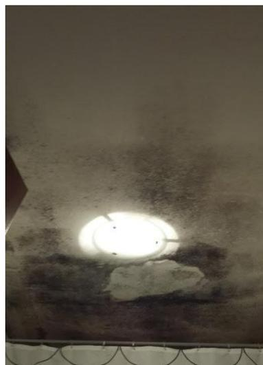
**Figura 4.11** Teto com humidade provocada por infiltração
