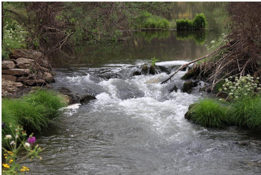
Figura C.18 - Parte do açude que foi destruída, permitindo a passagem dos peixes
