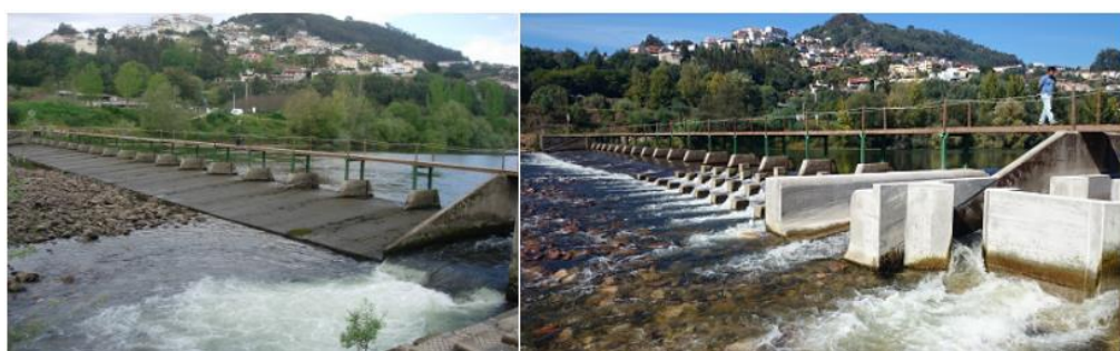
Figura 20 - Açude da Carvoeira (ou Açude de Reconquinho) (à esquerda: antes da intervenção; à direita: após a intervenção, caudal estival) (Fonte: http://www.rhpdm.uevora.pt/ )
