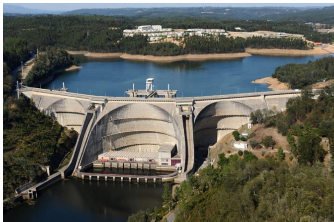
Figura 17 - Barragem da Aguieira (fonte: edp.pt)
