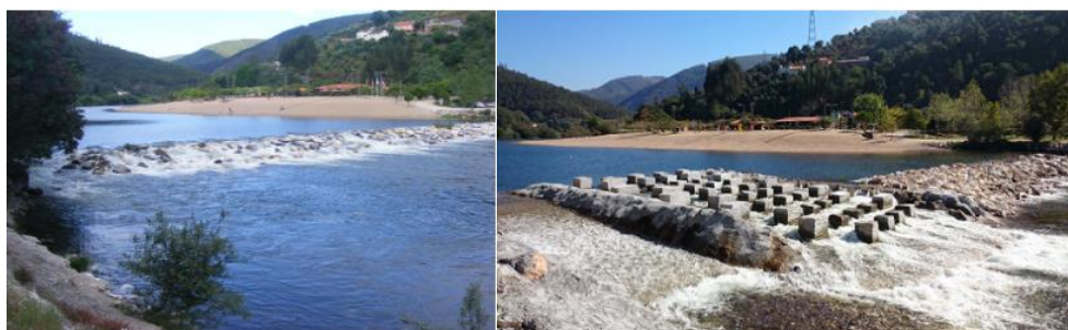
Figura 24 - Açude de Palheiros (à esquerda: antes do projeto; à direita: depois do projeto, caudal estival) (Fonte: http://www.rhpdm.uevora.pt/ )
