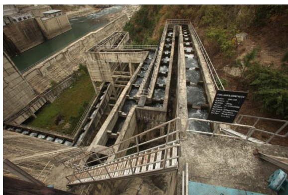
Figura 13 - Sistema de bacias sucessivas no Aproveitamento Hidroelétrico de Kurichhu (fonte: SANDRP, 2014)
