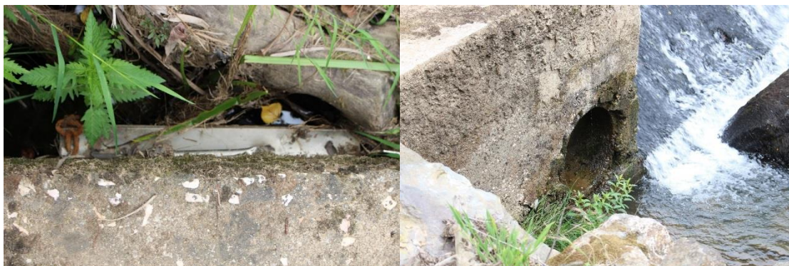
Figura C.23 - Comporta (à direita) e conduta (à esquerda) observadas a jusante e montante do Açude 2, respetivamente
