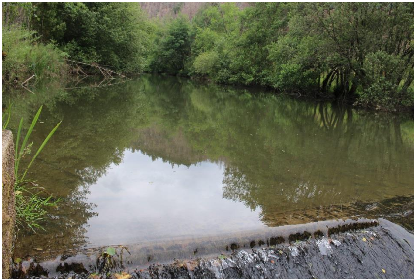
Figura C.21 - Comportamento lântico a montante do Açude 2
