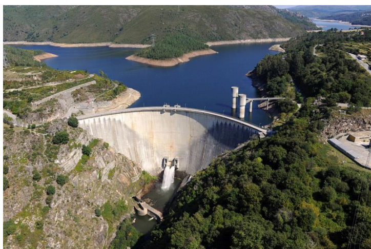
Figura B.1 - Barragem do Alto Lindoso (fonte: edp.pt)
