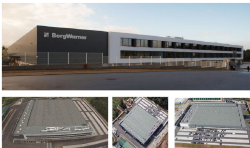
Figura 2 - Instalações da BorgWarner Emissions Systems Portugal
