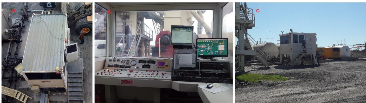
Figura 5. 6 – A) Exterior da cabine da central de Benafessim; B) Interior da cabine da central de Benafessim; C) Exterior da central do Passil; [Fonte: Própria]
