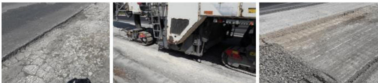
Figura 5. 4 – Saneamento do pavimento no local da anomalia [Fonte: Própria]
