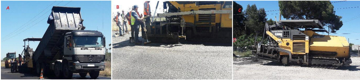
Figura 5. 14 – A) Camião a descarregar mistura SMA na pavimentadora; B) Mistura a sair na mesa de espalhamento e equipa de pavimentação; C) Pavimentadora ABG7820; [Fonte: Própria]
