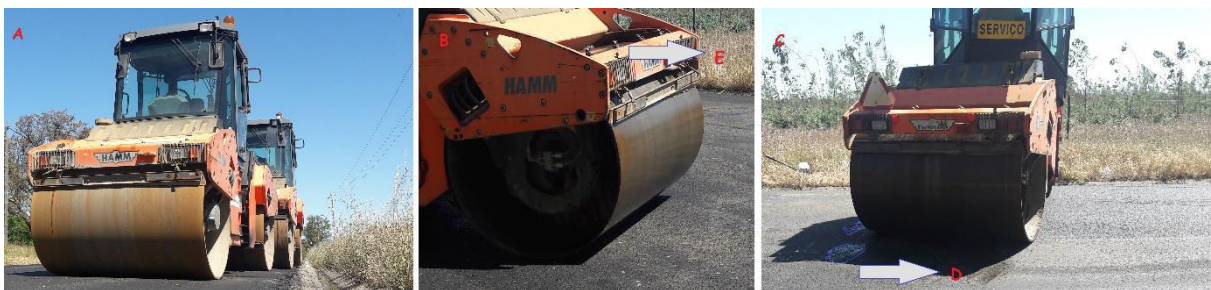
Figura 5. 15 – A) Cilindros HAMM HD90 desligados; B) e C) Cilindro HAMM HD90 ligado; D) Mancha de água libertada pelos aspersores; E) Aspersores ligados; [Fonte: Própria]
