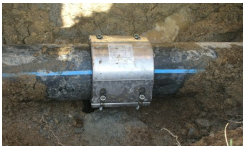
Figura 18 – Reparação de uma avaria (rotura de conduta distribuidora)
