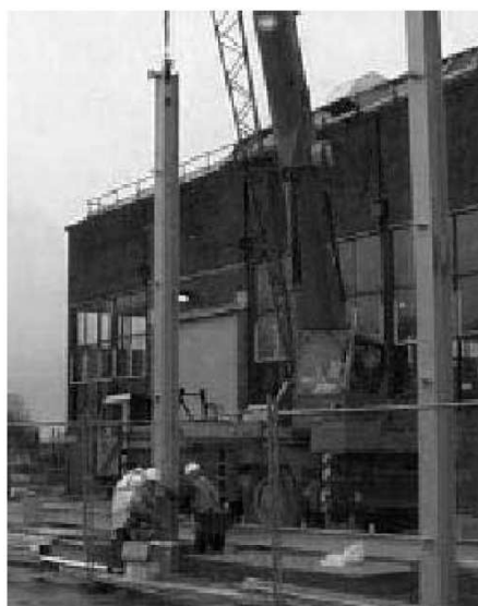
Figure 5: Pilar posicionado verticalmente
