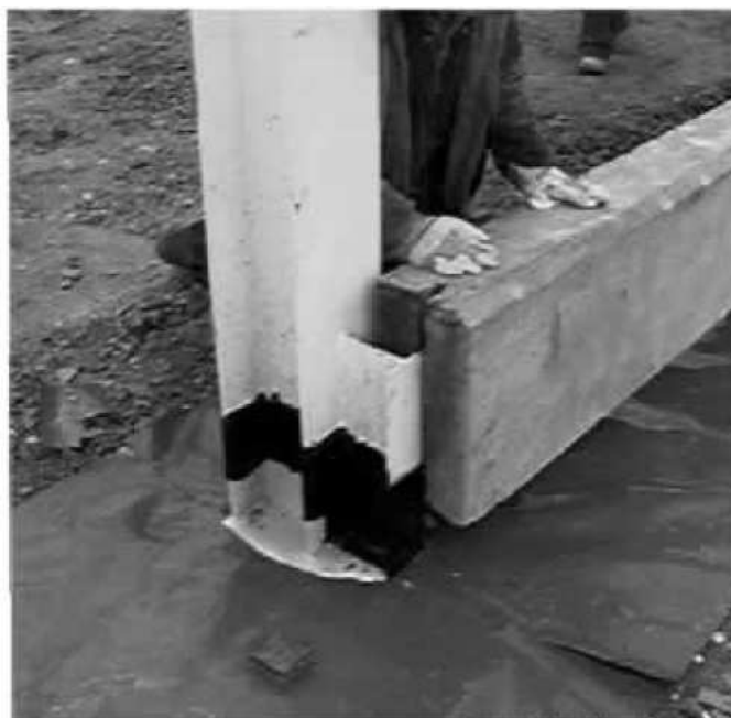
Figura 7: O lintel pré-fabricado a ser posicionado sobre o T
