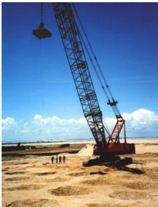
Figura 1.5. Compactação dinâmica – Aeroporto de Changi – Singapura – Peso 25ton; Altura de queda 25m (Massarsch, 2004)
