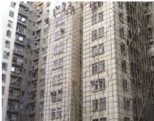
Figura 5.37 - Andaime em Bambu com Ligações em fio de aço [3]
