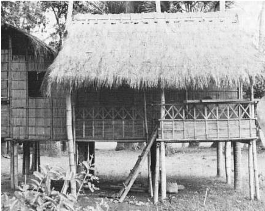
Figura 5.28 – Habitação de estrutura vernacular de bambu [7]
