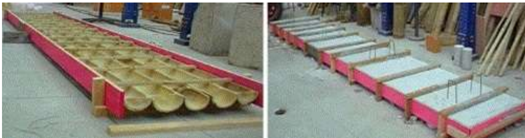
Figura 6.8. – Antes e Depois da Betonagem [30]
