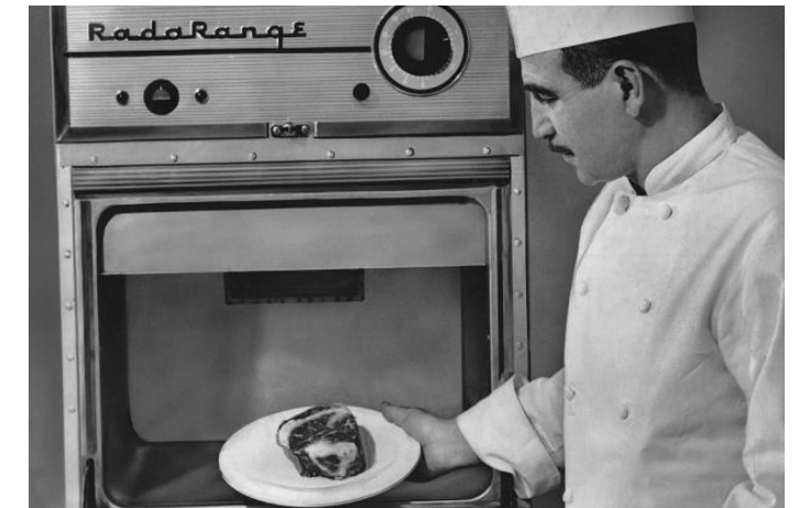
Fig. 20. Micro-ondas “Radarange”, da Raytheon Company, modelo de 1947, que tinha quase 1,80 m de altura e pesava 340 quilos.
