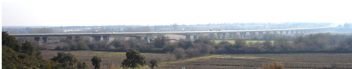
Figura 7.21 Imagem da ponte e viaduto da A13, sobre o rio Sorraia
