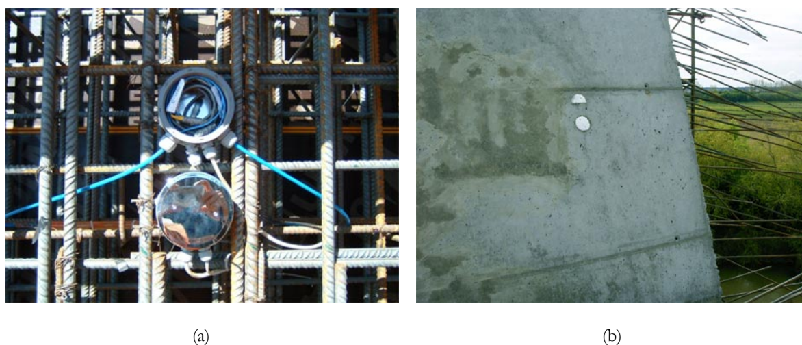
Figura 7.31 Imagens das caixas de ligação aos sensores embebidos: (a) antes da betonagem; (b) depois da betonagem
