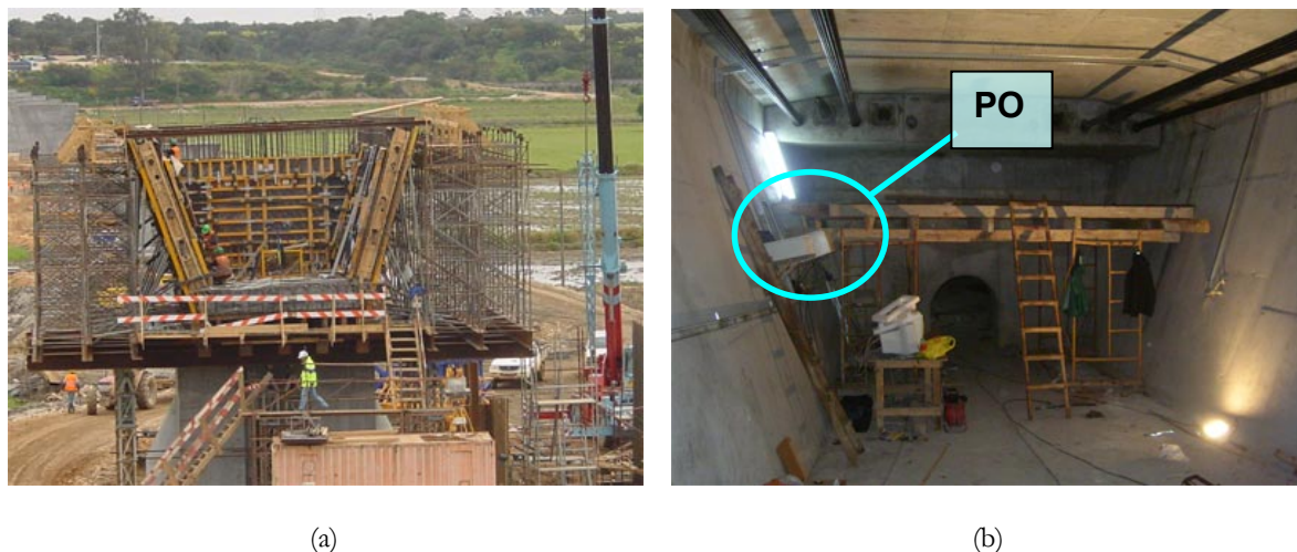
Figura 7.32 Imagens da secção S2: (a) durante a fase de construção; (b) no seu interior depois de terminada a construção, com o Posto de Observação (PO) instalado
