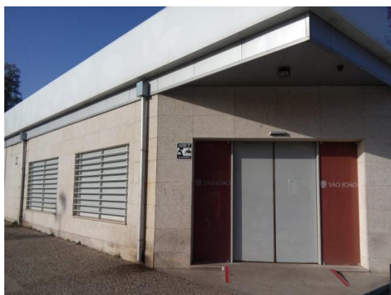
Anexo XLII – Instalações da UFA do HSJ.
