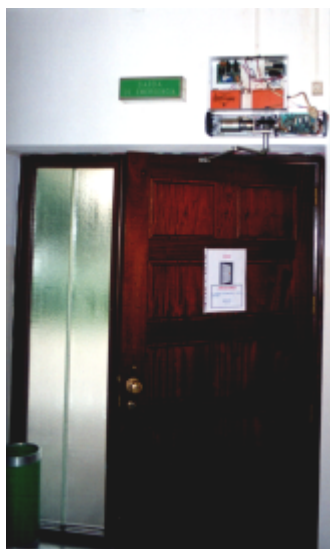
Figura 6.4: Módulo de controlo da Porta exterior
