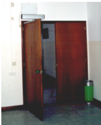
Figura 6.9: Porta interior e respectivo actuador
