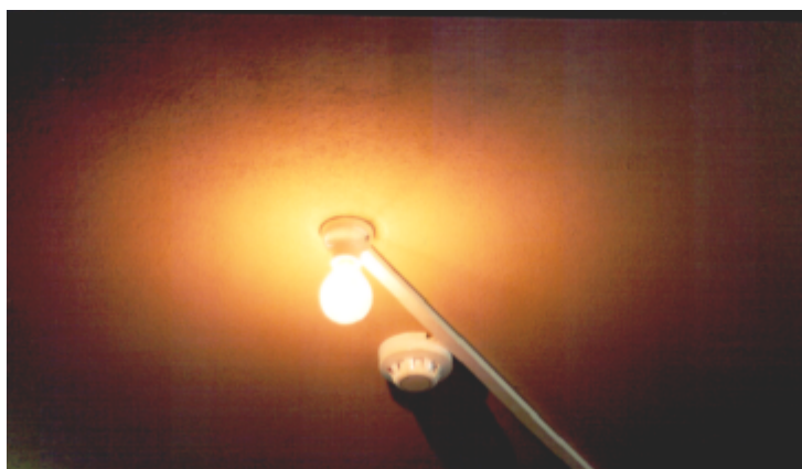
Figura 6.5: Módulo de controlo lâmpada
