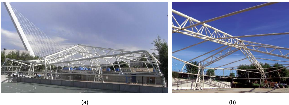
Figura 5.2 – Estrutura metálica tubular da cobertura: (a) Vista exterior (Performance S.L. 2010) e (b) Vista Interior (Escrig et al. 2012)
