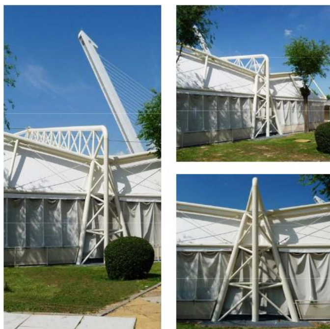
Figura 5.3 – Vistas do pilar do pórtico maior da estrutura metálica (Sanrocon 2009)
