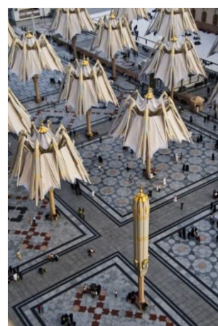
Figura 4.45 – Monitorização de estruturas de cobertura em membrana tensa: (a) Estádio de Seogwipo (Ojakgyoo 2001), Coreia do Sul e (b) Múltiplas coberturas de sombreamento na praça de Medina (Architect 2010), Arábia Saudita
