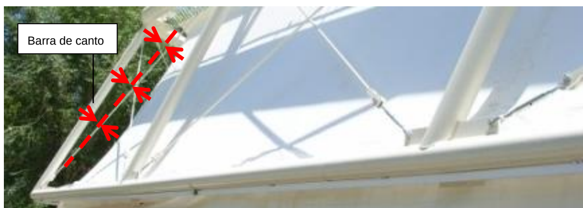
Figura 5.18 – Ligação da membrana dos módulos 2 e 3 à barra de canto
