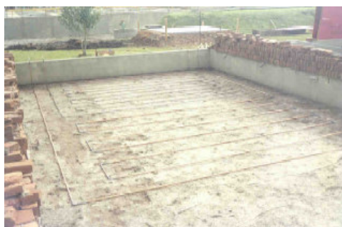
Figura 3.7 - Pormenores do leito de secagem com as condutas para aquecimento e com a estufa plástica sobre o mesmo 70
