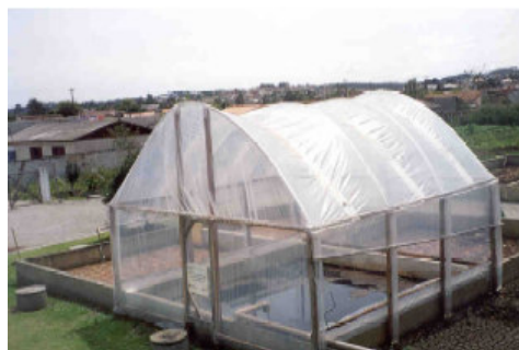
Figura 3.7 - Pormenores do leito de secagem com as condutas para aquecimento e com a estufa plástica sobre o mesmo 70
