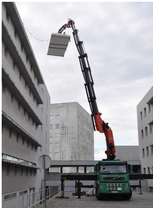
i. 67. Transporte de painéis pré-fabricados para o topo do edifício.
