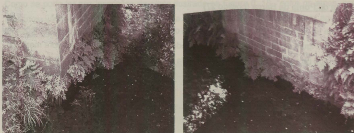
Figura 6. 15 - Pormenores da parte inferior dos encontros (Nascente e Poente)
