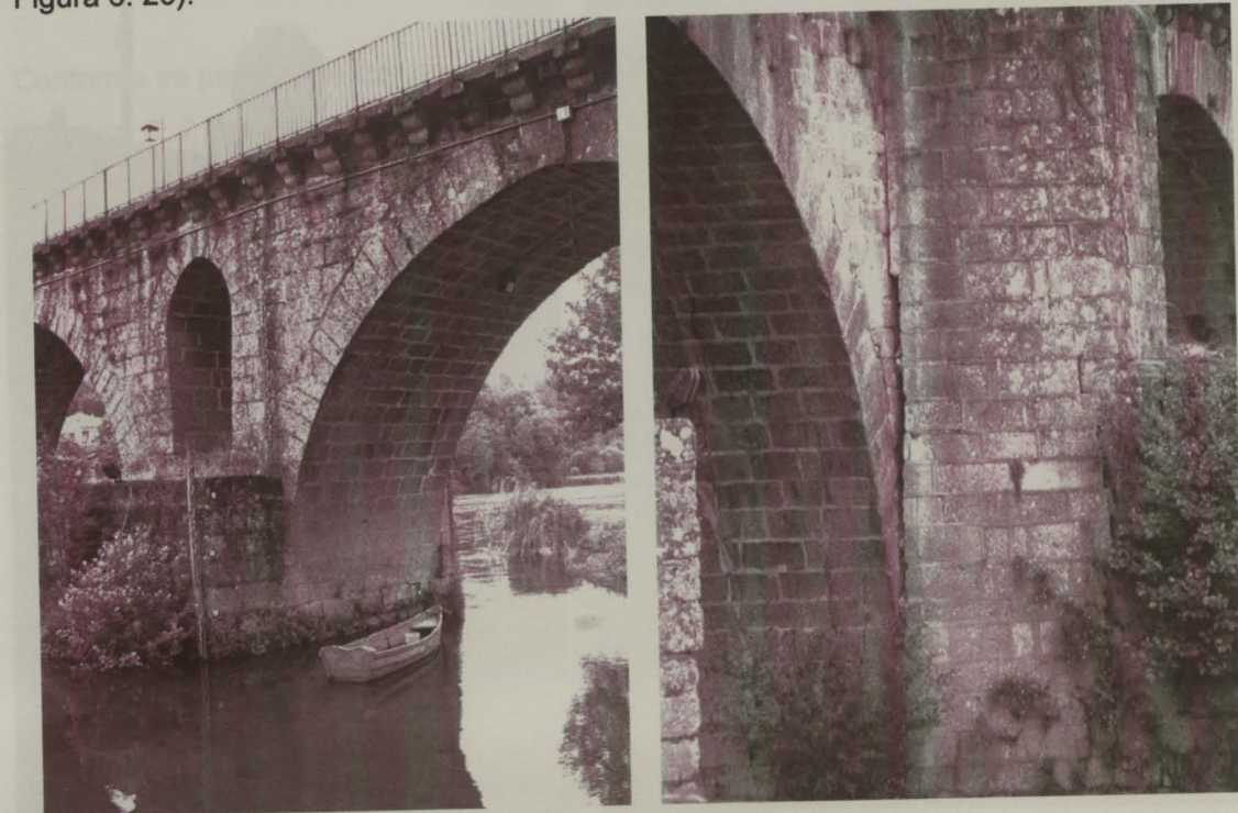
Figura 6. 20 - Pormenores dos muros tímpano
