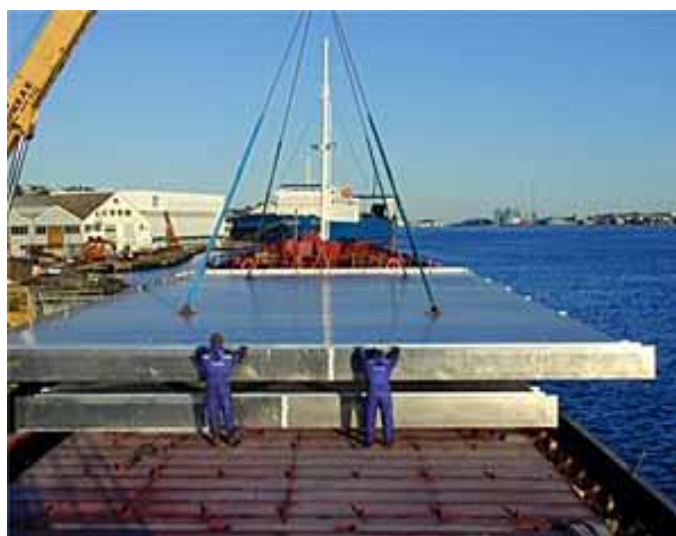
Figura 2.18 - Soldadura de convés de navio pelo processo FSW [49]
