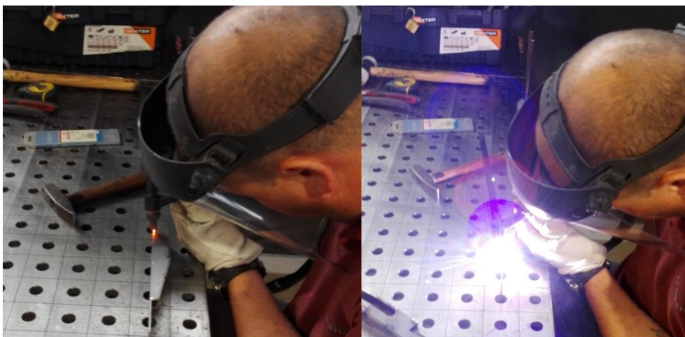
Figura 56 – Soldadura TIG manual dos conjuntos 0657669/0657670
