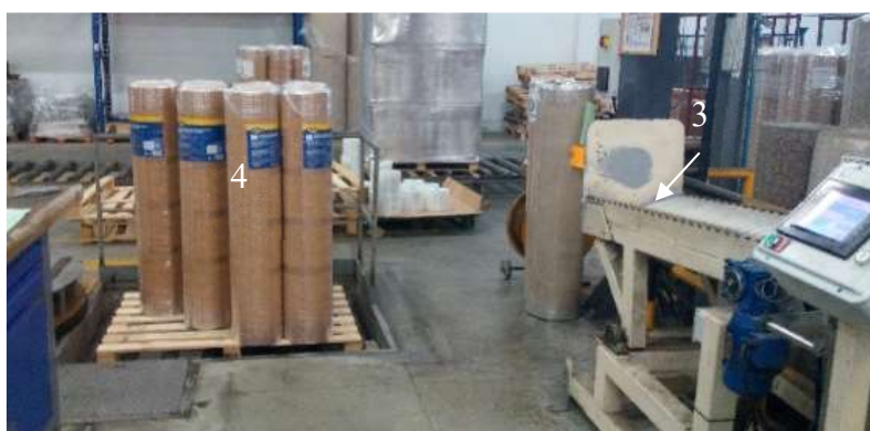
Figura 25 - Rolos prontos na paleta (4) e plataforma auxiliar (3)
