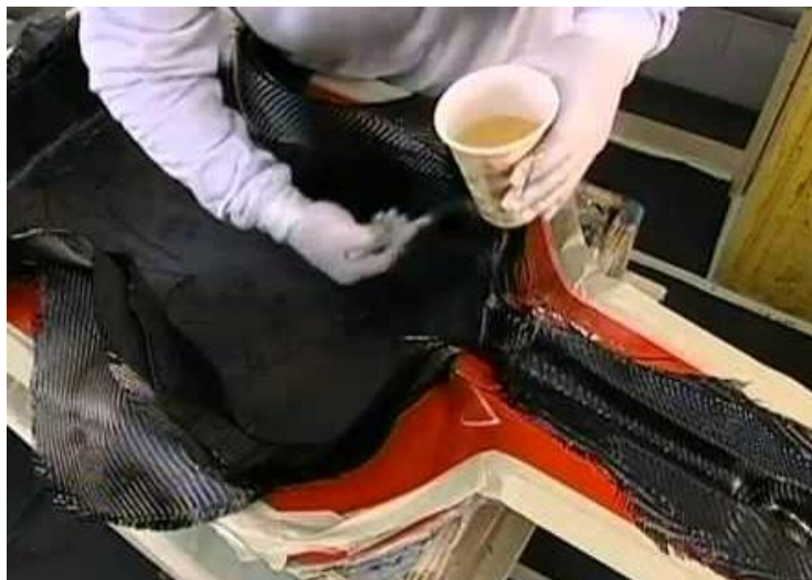
Figura 9 - Aplicação da resina nas camadas de fibra de carbono (fonte: (Pinterest s.d.))
