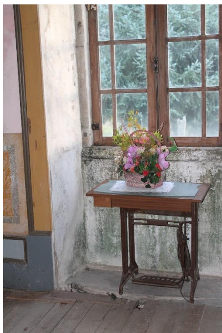
Figuras 4.20 e 4.21 – Anomalias visíveis causadas pela humidade.
