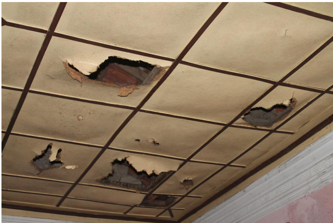
Figura 4.12 – Tela que reveste os tetos nas divisões mais amplas.
