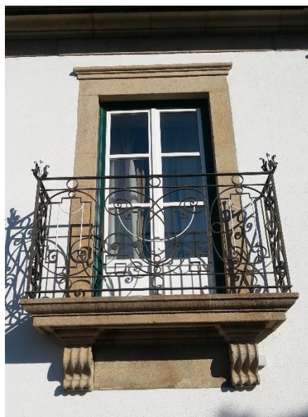
Figuras 5.10 e 5.11 – Pormenor das caixilharias de madeira a executar. [29]
