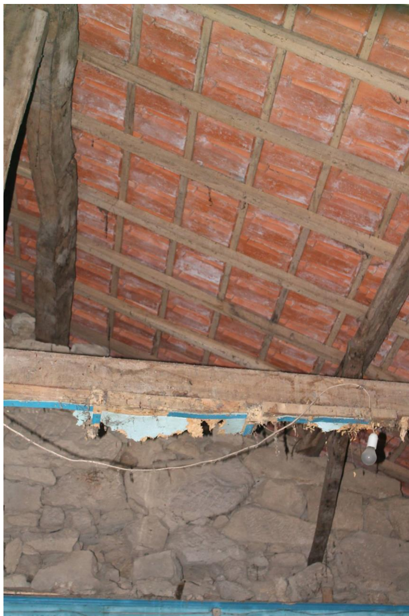
Figura 4.14 – Vista do desvão da cobertura.
