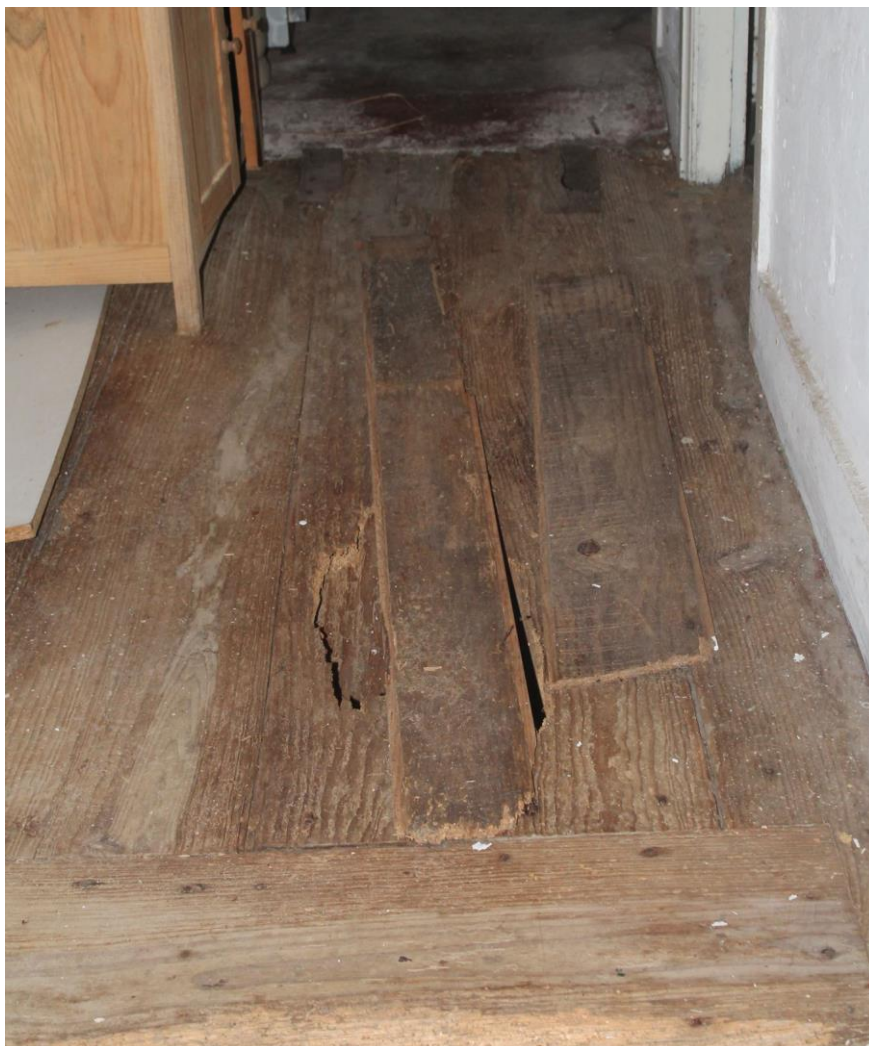
Figura 4.10 – Pavimento interior – vista superior do soalho em madeira de pinho.
