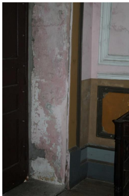
Figuras 4.20 e 4.21 – Anomalias visíveis causadas pela humidade.
