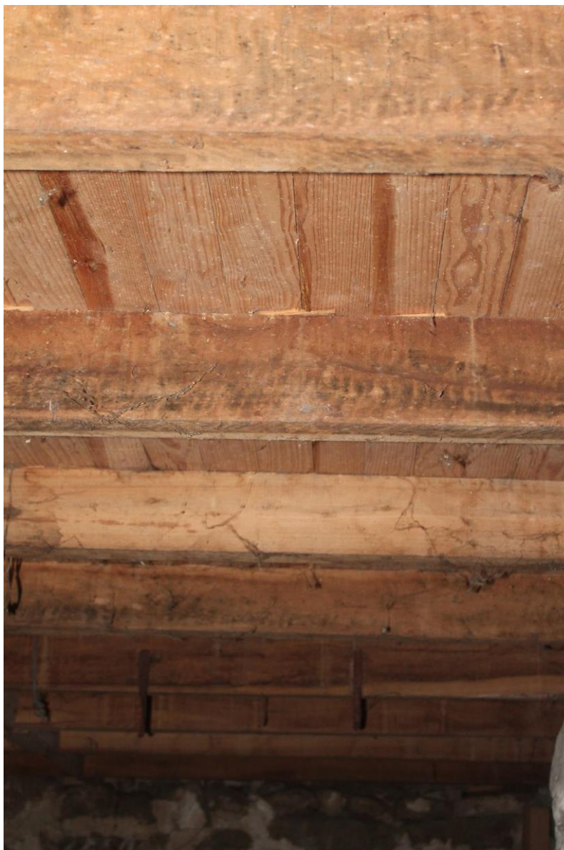
Figura 4.11 – Vista da estrutura em madeira do teto da cave.
