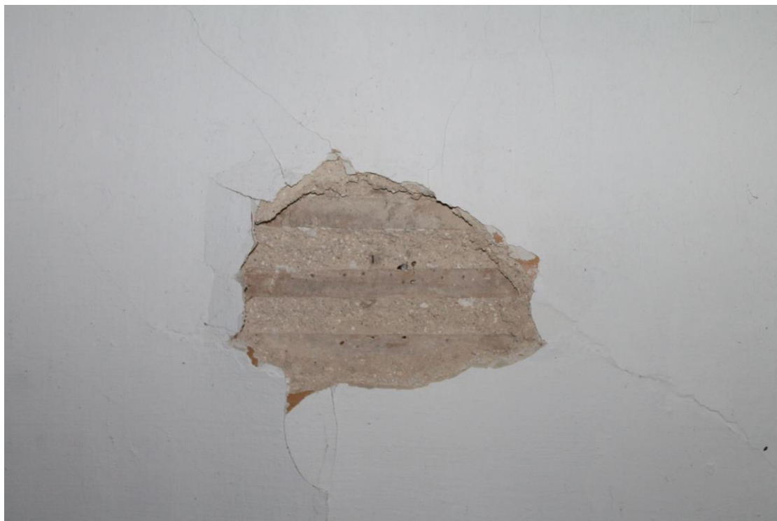
Figura 4.9 – Parede interior em tabique – sondagem “natural”.
