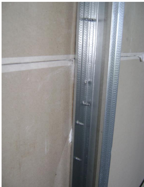
Figuras 5.3, 5.4 e 5.5 – Pormenores da construção de divisões interiores. [26]
