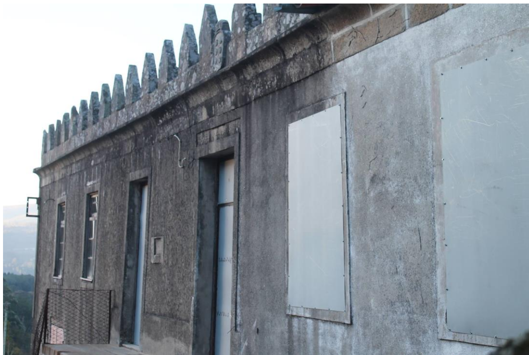
Figura 4.8 – Vista das paredes exteriores da moradia (alçado principal).
