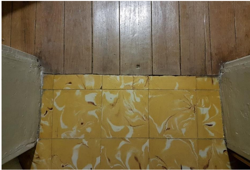
Fig.40 – Transição do Pavimento em Madeira para o Pavimento em Mosaico
