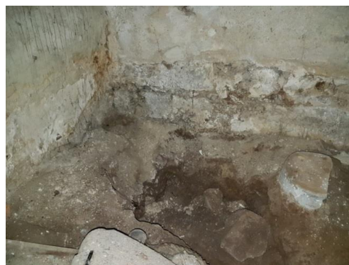
Fig.36 – Fundação Contínua em Alvenaria de Pedra
