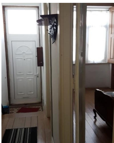
Fig.39 – Parede Interior em Tabique
