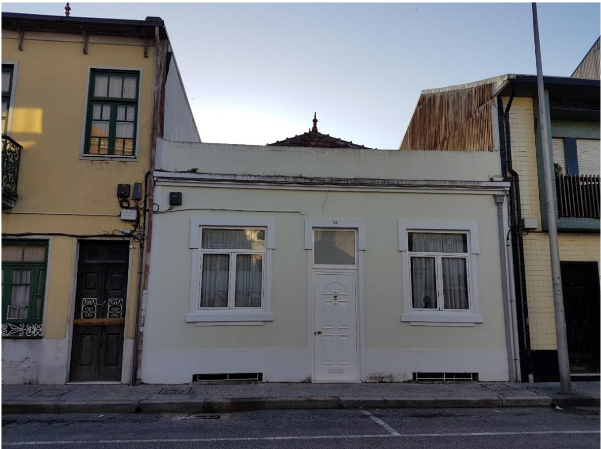
Fig.37 – Fachada Principal do Edifício
