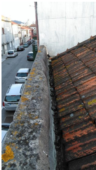
Fig.46 – Pormenor do Tipo de Algeroz de Remate da Tacaniça com a Platibanda
