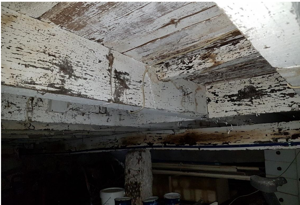
Fig.42 – Estrutura de Suporte do Pavimento
