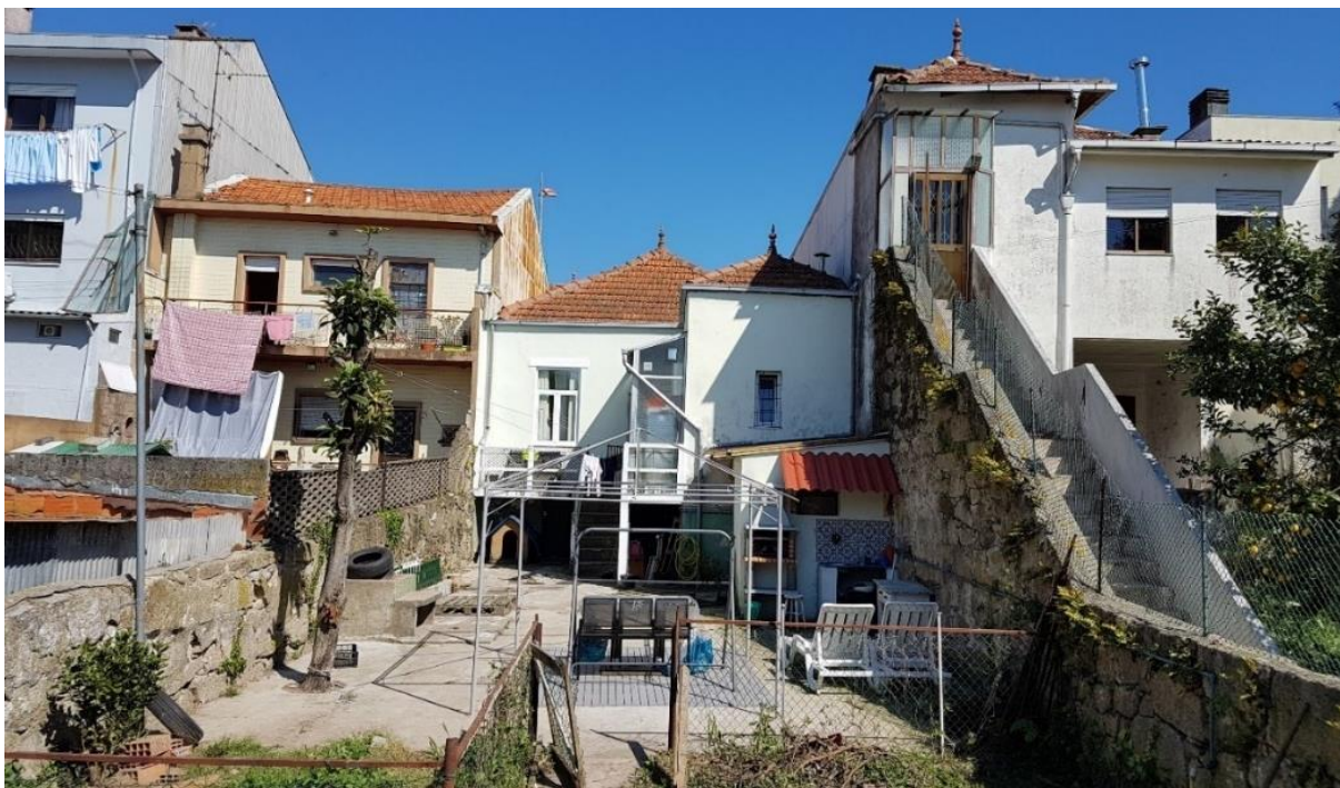
Fig.38 – Fachada Tardoz do Edifício
