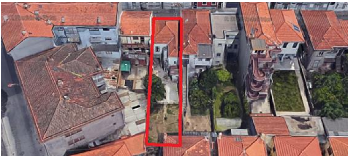
Fig.30 – Outra Vista Aérea do Edifício
