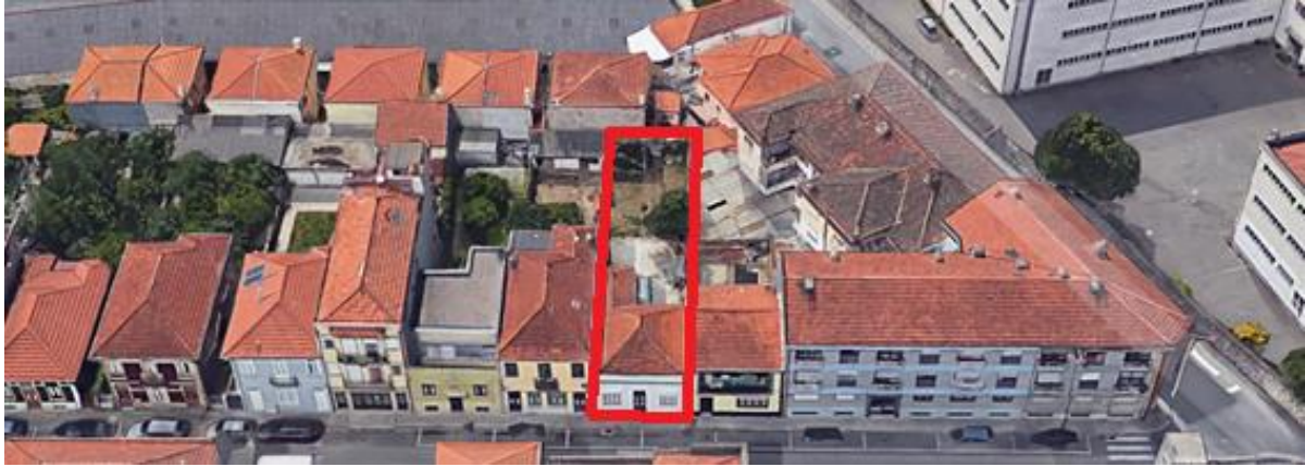
Fig.29 – Vista Aérea da Rua de Dionísio de Pinho
