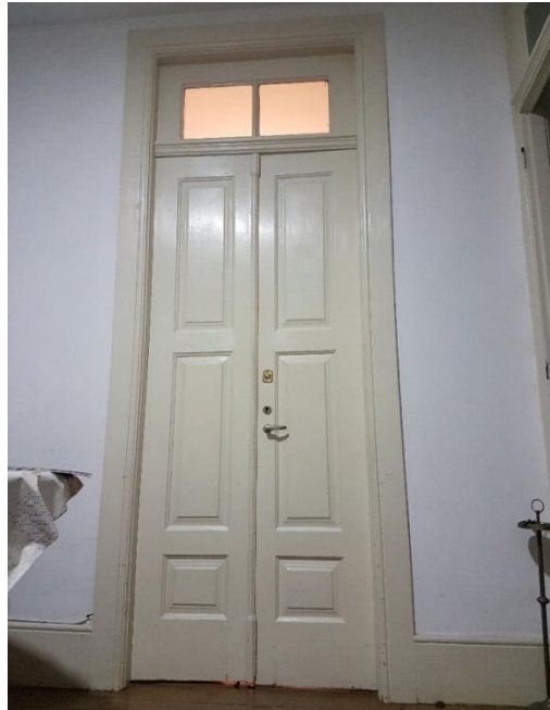
Fig.48 – Caixilharia Interior em Madeira
