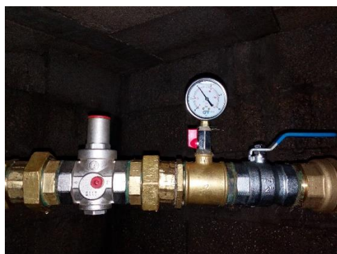
Figura 5.6 – VRP Vila de Mansores 3
