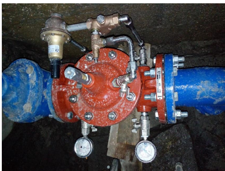
Figura 5.5 – VRP Vila de Mansores 2
