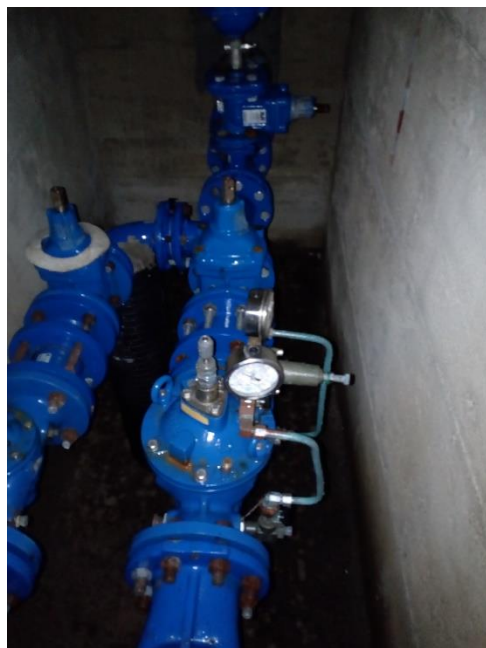
Figura 5.4 – VRP Vila de Mansores 1
