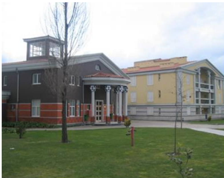
Fotografia 1 - Foto complexo Residência polo da Asprela
