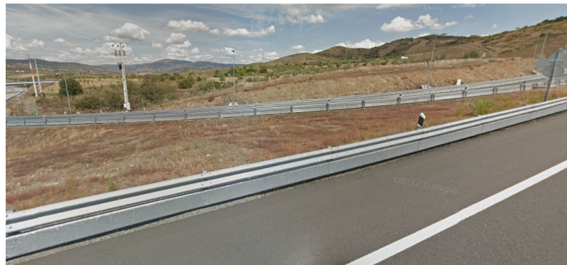
Figura 6.6: Local da Instalação
