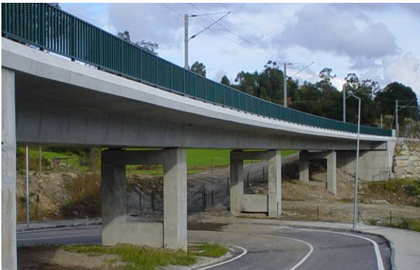
Figura 4.14 – Vista geral do viaduto
