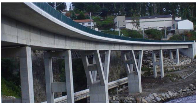
Figura 4.9 – Vista geral da ponte
