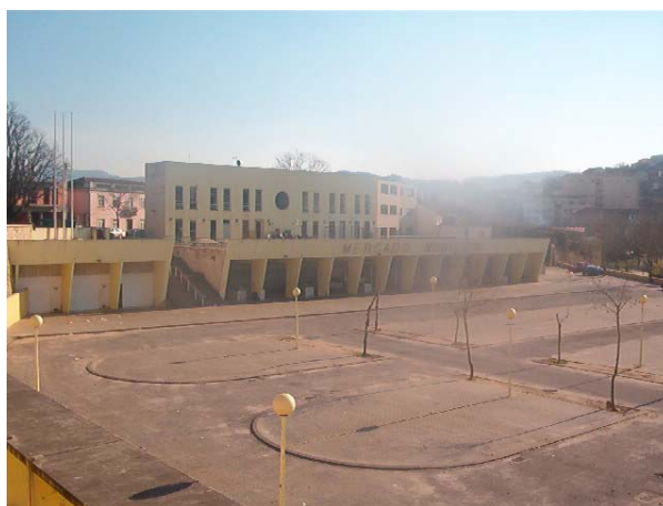
Figura 34: Local da antiga Estação Central de Camionagem de Celorico de Bastos
