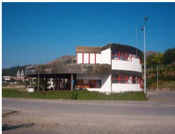
Figura 54: Estação Central de Camionagem de Vila Nova de Cerveira
