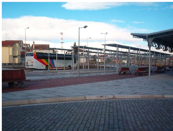
Figura 63: Estação Central de Camionagem de Bragança
