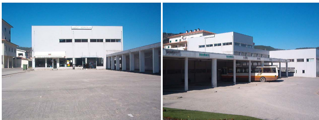
Figura 45: Estação Central de Camionagem de Vila Pouca de Aguiar
