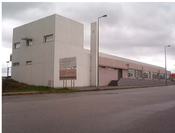
Figura 44: Estação Central de Camionagem de Valpaços
