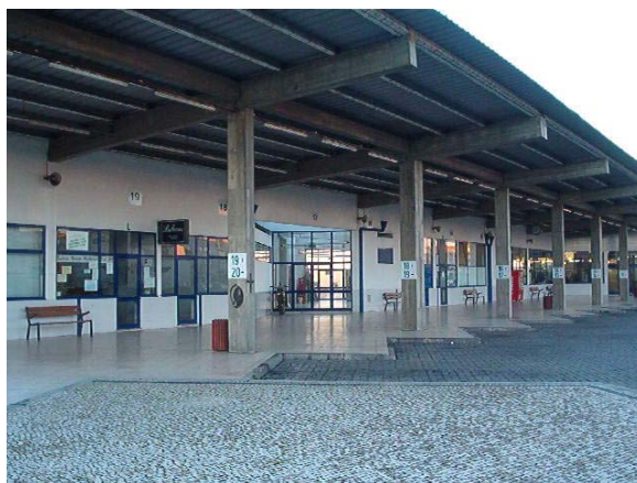
Figura 56: Estação Central de Camionagem de Póvoa de Varzim
