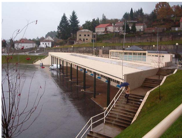
Figura 61: Estação Central de Camionagem de Montalegre
