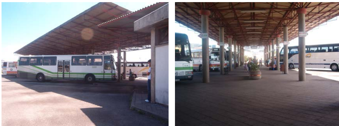
Figura 48: Estação Central de Camionagem de Viana do Castelo
