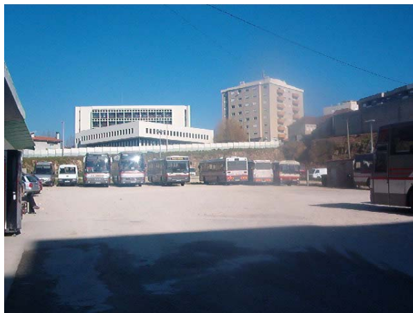
Figura 49: Local de carga e descarga de passageiros em Vila Real
