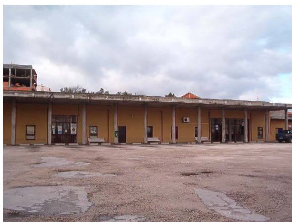
Figura 39: Estação Central de Camionagem de Moimenta da Beira
