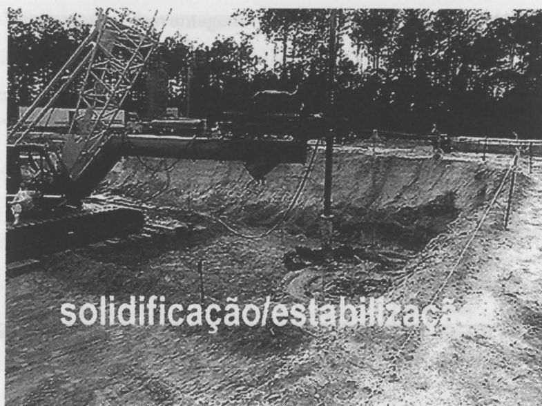
Figura 1.20 – Sistema de solidificação/estabilização in-situ [adaptado de net(13)].
