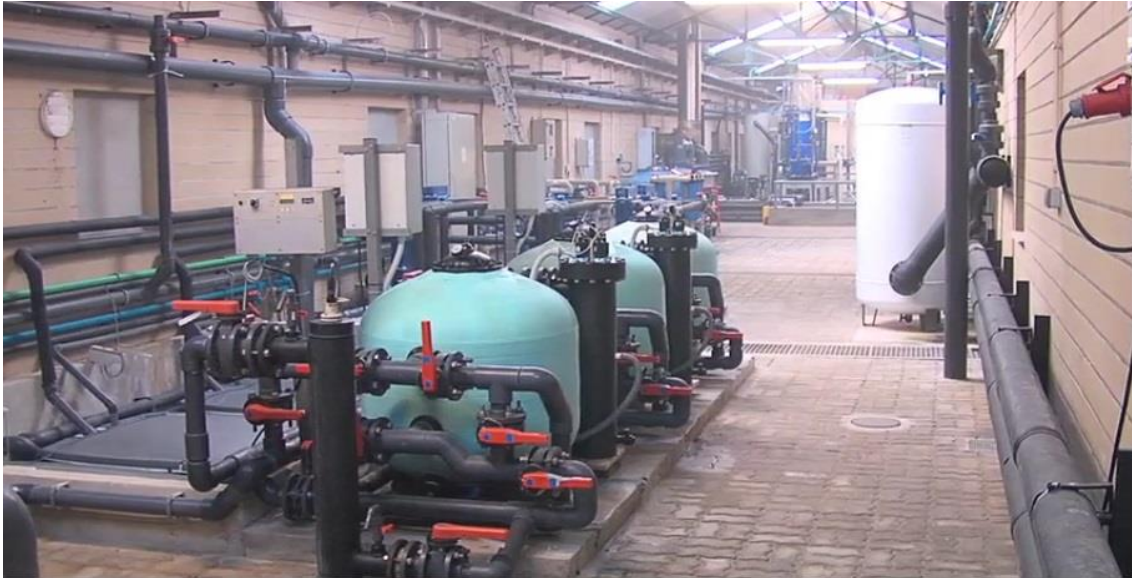
Fig. 22 – Filtros Mecânicos: Filtro de Areia (na frente) e Protein Skimmer (no fundo; coluna azul) (Sea8)
