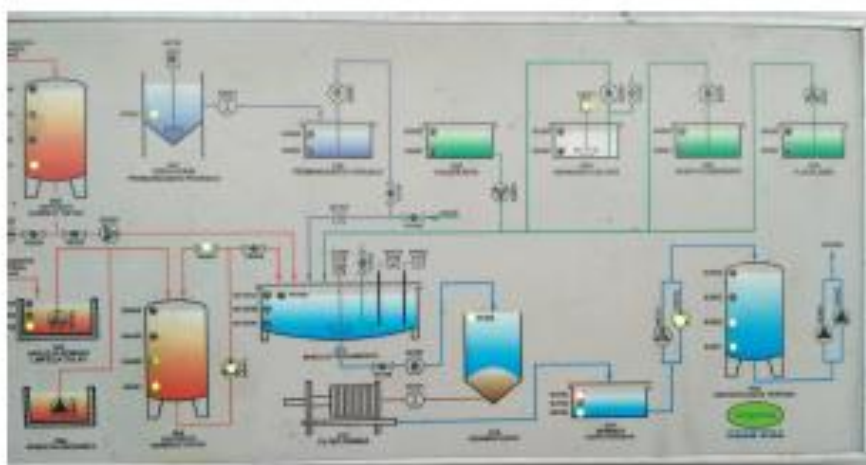
Figura 2 – Quadro de controlo da ETAR
