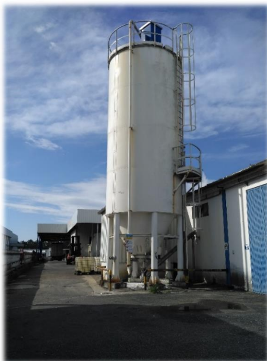
Figura 27 - Tanque de armazenamento de amido de milho
