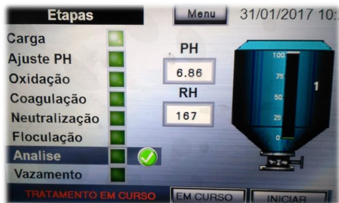
Figura 33 – Autómato da ETARI (etapas de tratamento)
