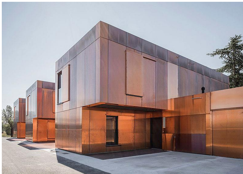
Figura 2 - Aplicação do Cobre na Arquitetura Moderna ( http://archidesignclub.com/magazine/rubriques/architecture/46170-lcr-architectes-coll%C3%A8ge-de-labarthe-sur-l%C3%A8ze.html )
