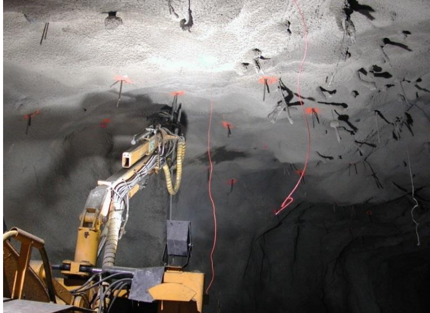
Figura 65 – Colocação de parafusos no teto. Betão projetado nos hasteais e no teto.
