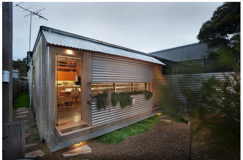
Figura 4 - Aplicação do zinco na construção civil ( http://www.limaonagua.com.br/decoracao/decoracao-criativa-e-reducao-de-custos-de-reforma-utilizando-telha-galvanizada/ )
