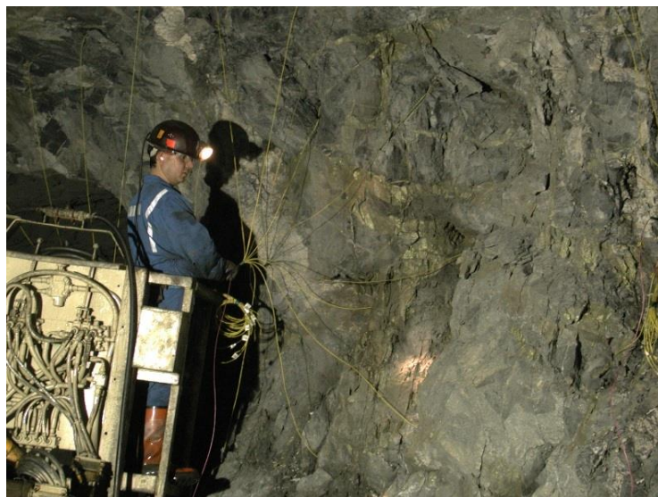
Figura 53 - Colocação de explosivos numa frente de produção de minério fissural (FC)
