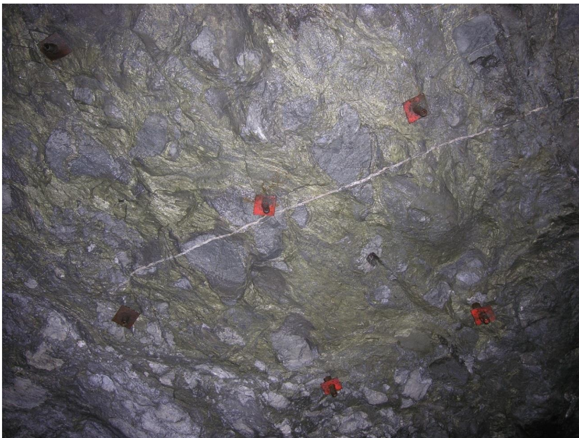
Figura 17 - Stockwork de Cu (FC), num hialoclastito no desmonte do Corvo C810_5R
