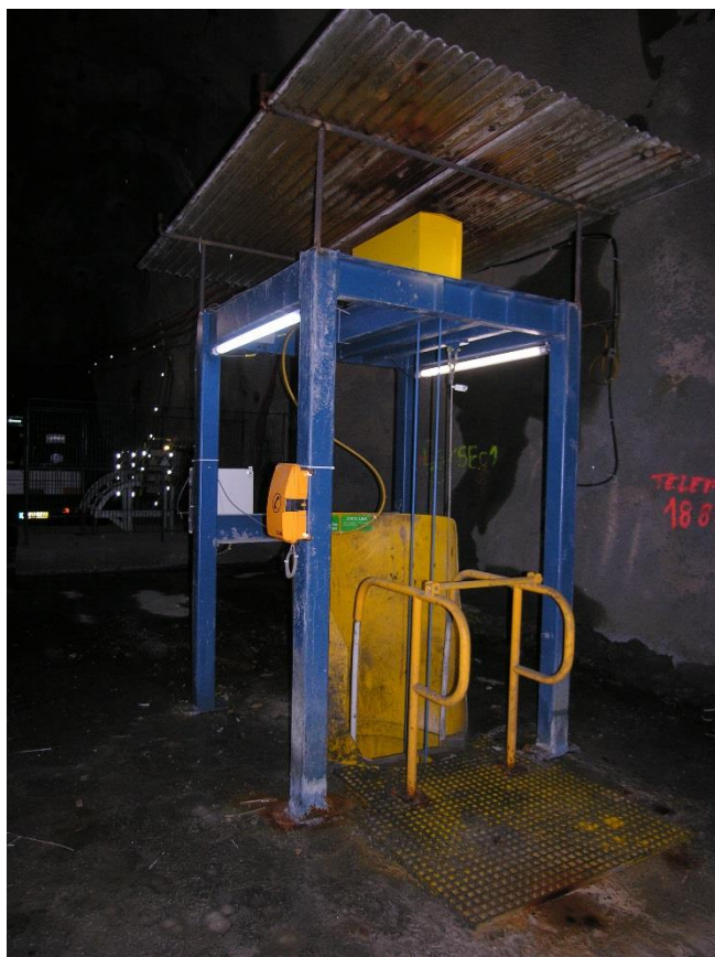
Anexo 10 – Escadas de emergência entre dois níveis
