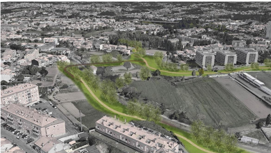
Figura 36 – Vista aérea da Ponte sobre a Linha Ferroviária
