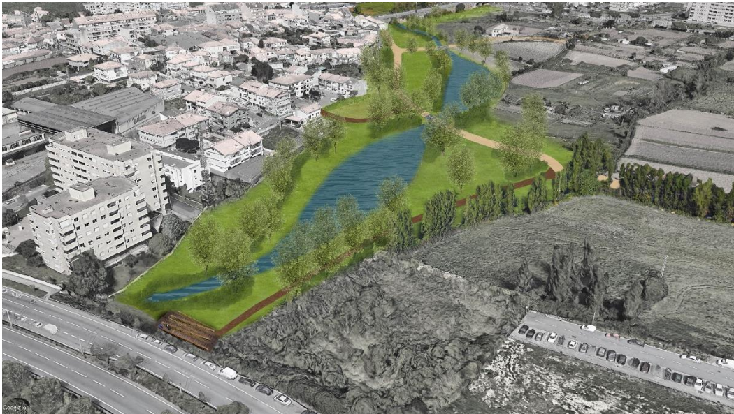
Figura 38 – Vista aérea da Parque da Circunvalação
