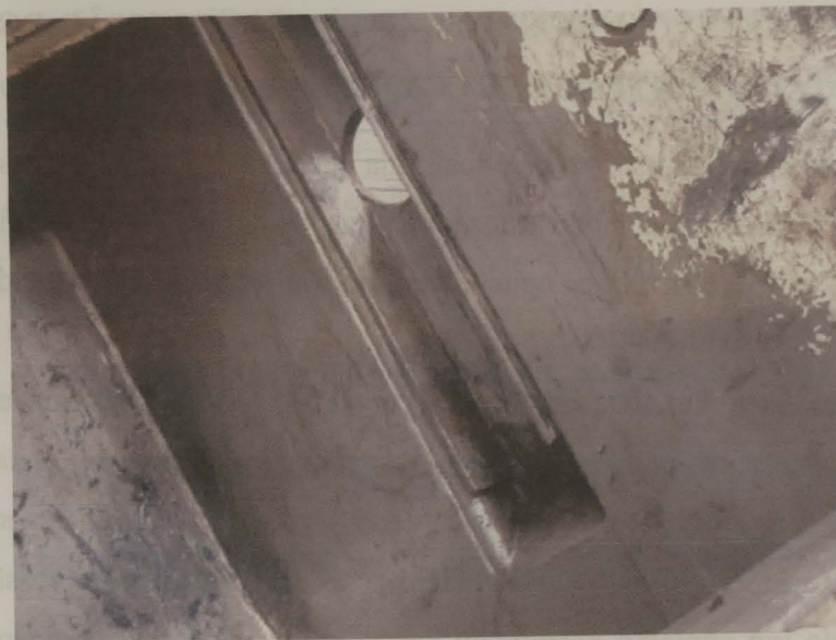
Figura 4.7 - Parte inferior da guia de deslizamento em bom estado de conservação.
