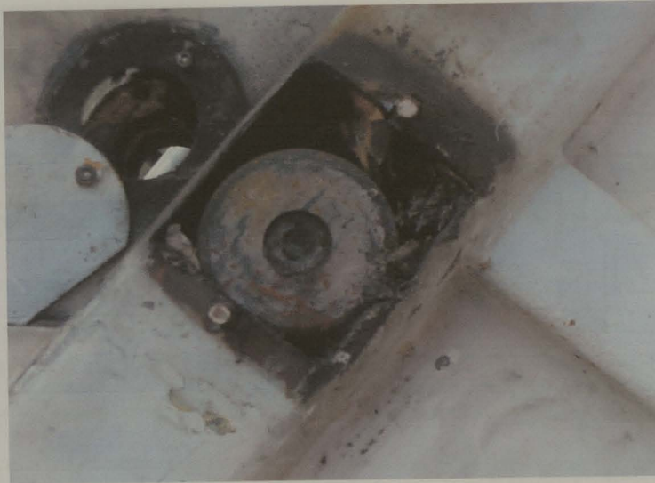
Figura 3.2 - Contaminação da pista de deslizamento do rolete, (verificação de rotina realizada após 24 horas de entrada em serviço).
