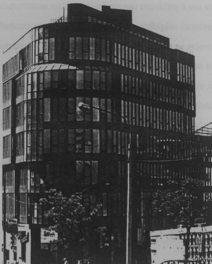
Fig.3 - Envidraçados num edifício urbano
