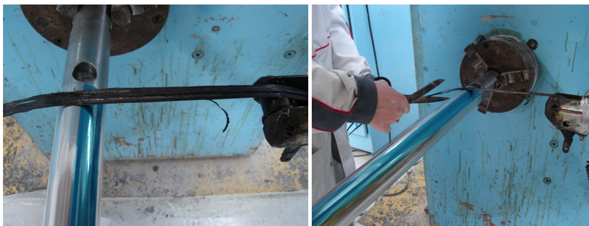
Figura 3.7a. Preparação para o início do enrolamento de tubagem.
