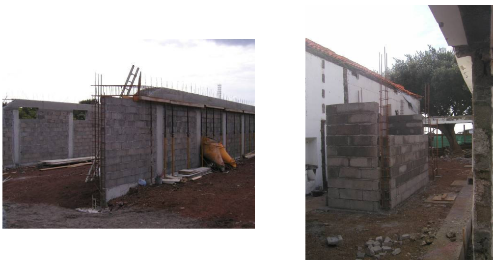
Figura 4.11 – Utilização de blocos em diversas obras.
