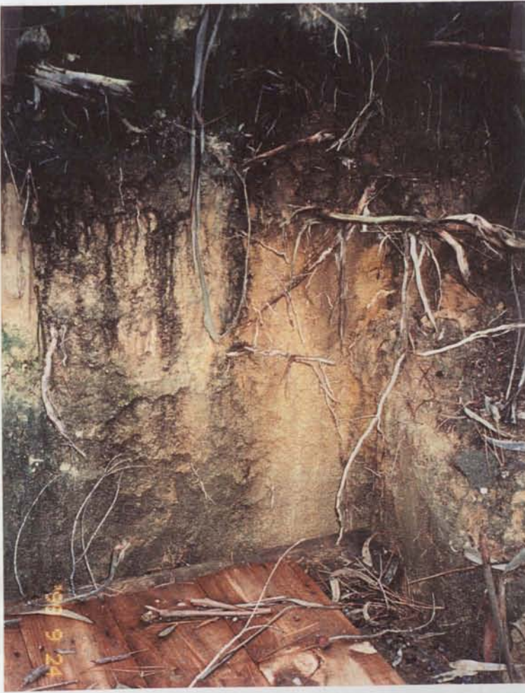
Figura 8.9 – Aspecto das paredes da vala aberta no solo residual de granito.
