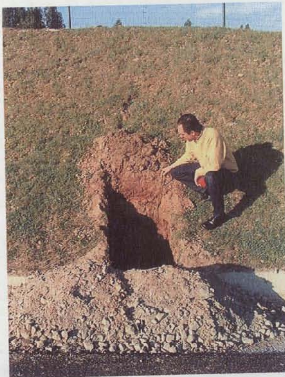
Figura 8.23 – Aspecto do talude e do poço aberto onde se efectuou a inspecção visual das condições in situ .
