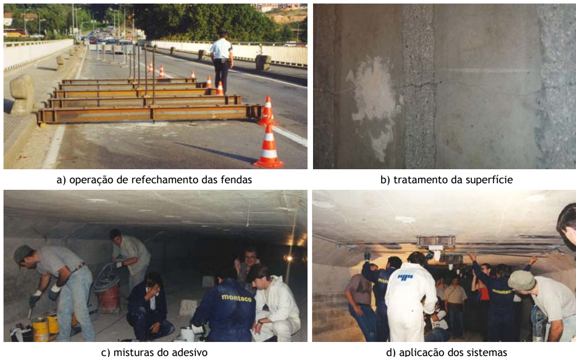
Figura C.3 – Fases de execução do reforço experimental.
