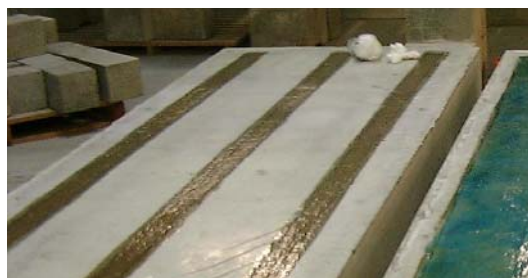
c) aplicação do primário
