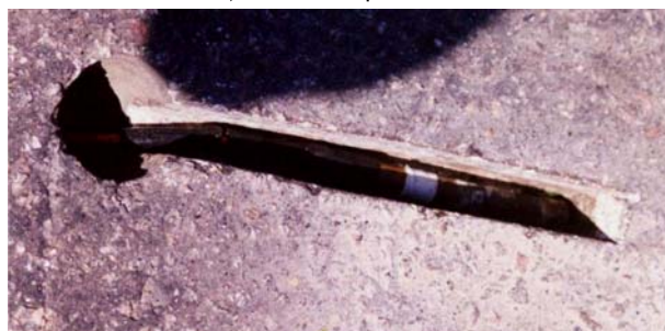
c) abertura do rasgo no betuminoso e colocação do sensor
