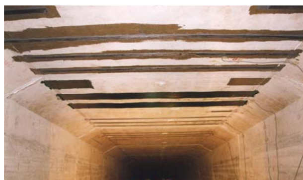
Figura 5.23 - Vista do interior do caixão durante e no final da aplicação do reforço experimental.
