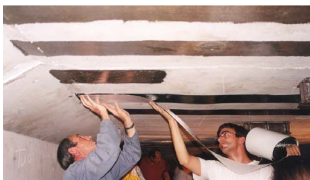
Figura 5.23 - Vista do interior do caixão durante e no final da aplicação do reforço experimental.
