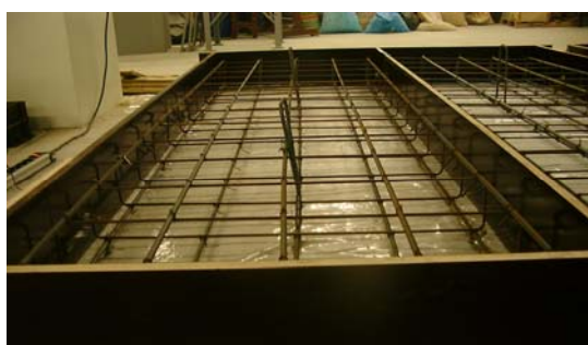
a) aspecto geral das armaduras
