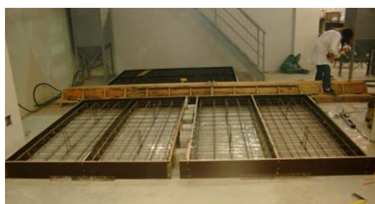
a) aspecto geral das armaduras
