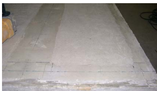
b) tratamento da superfície com esmeril
