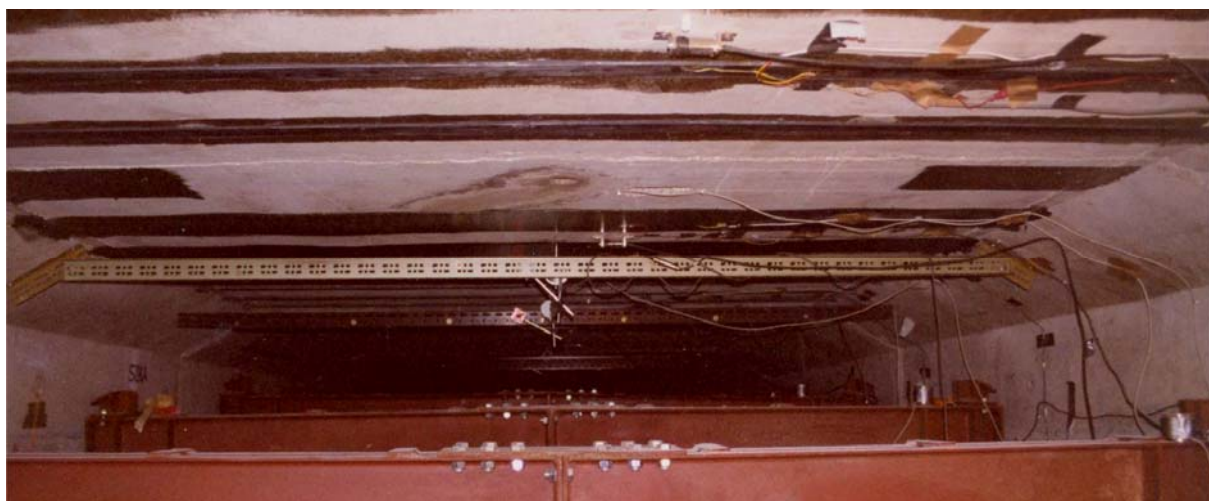
a) fixação das cantoneiras
