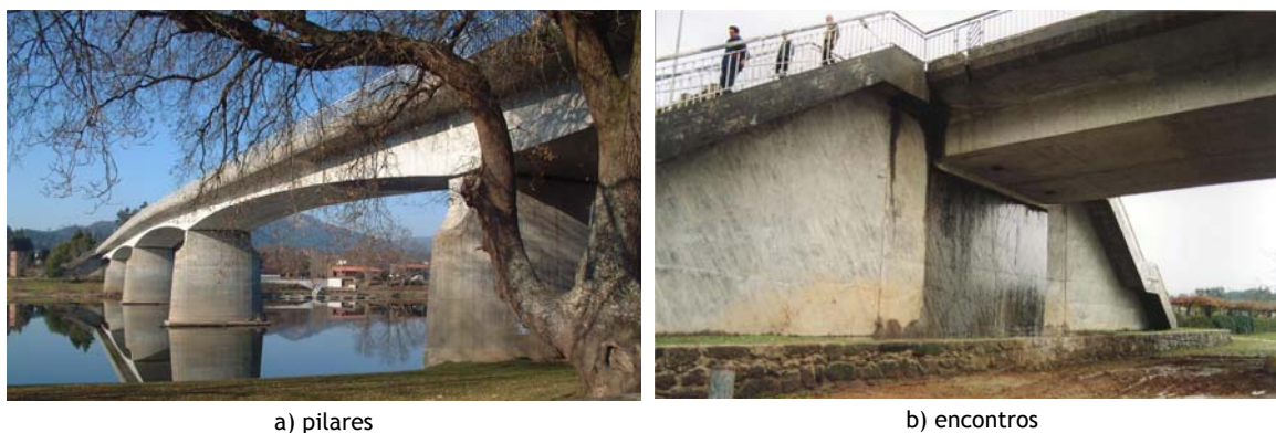
Figura 5.4 – Suportes do tabuleiro da ponte, pilares e encontros.
