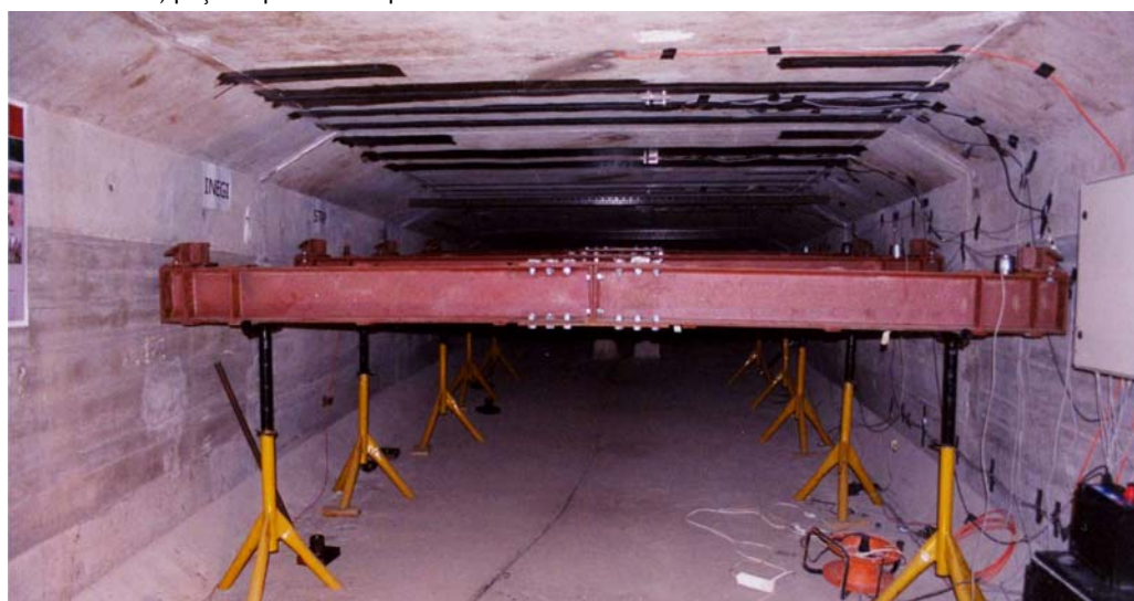
d) aspecto final das vigas
