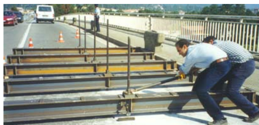
Figura 5.22 - Esquema utilizado para refecho das fendas.
