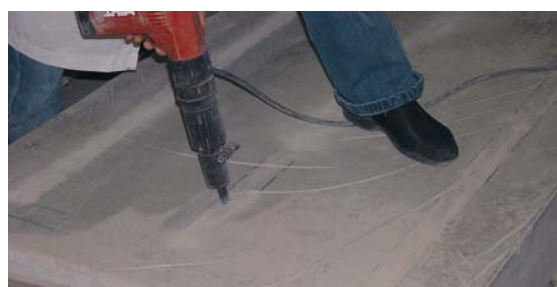
b) tratamento da superfície com martelo de agulhas
