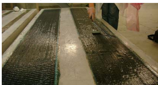
c) aplicação do sistema de CFRP
