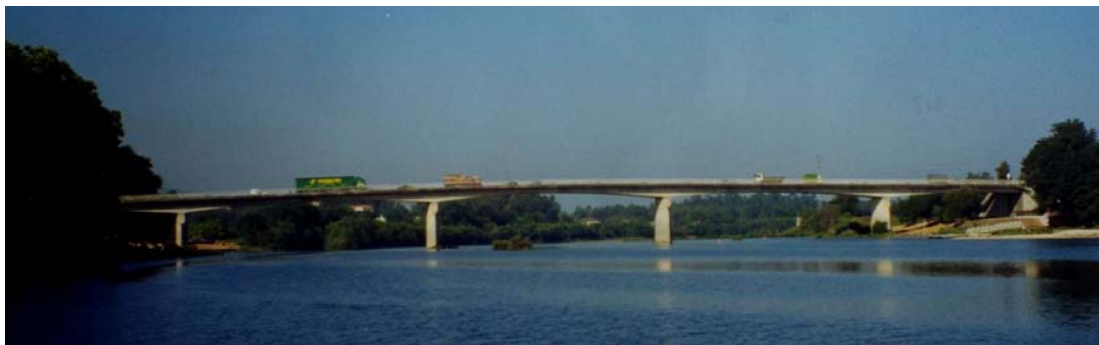
Figura 5.1 - Vista geral da Ponte de Nossa Senhora da Guia.
