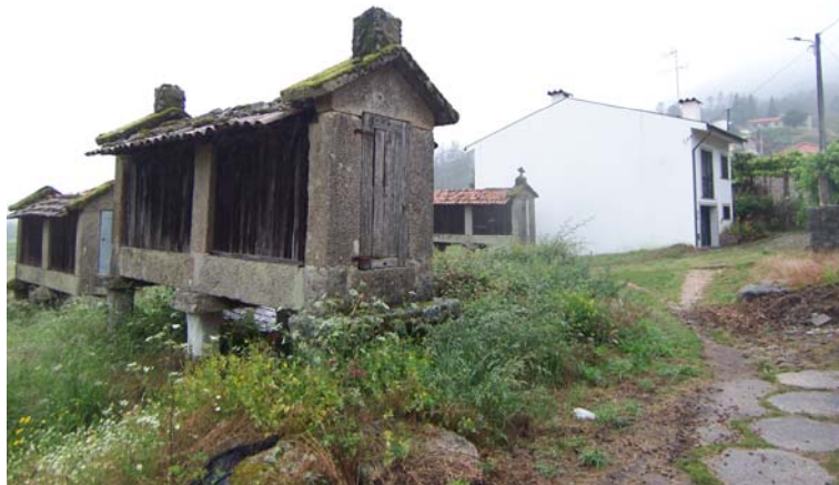
Foto 8 – Área dos espigueiros, contacto com construção abusiva
