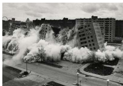
24.Demolição do conjunto habitacional Pruitt - Igoe (1972).
