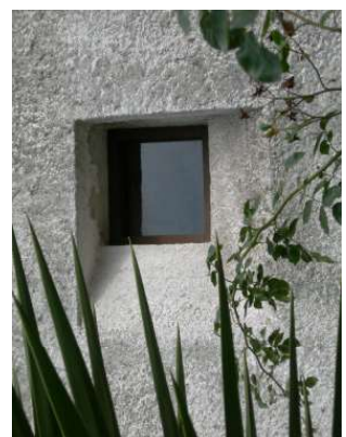
66. Vão da fachada Sul da moradia D.
