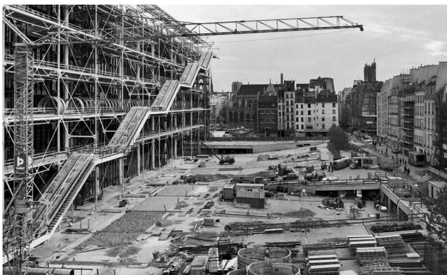
87. Construção do Centro e da Praça George Pompidou (1969).
